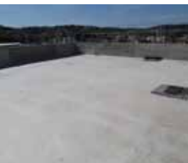
Preparazione del supporto
