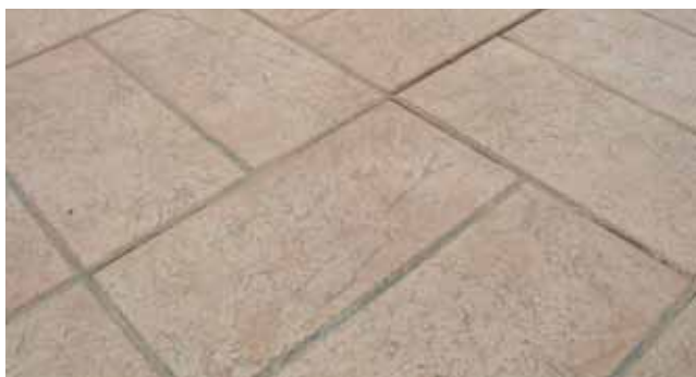
Pavimentazione in ceramica
