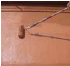
Stesura della membrana
