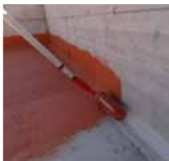
Stesura della membrana
