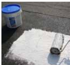
Stesura della membrana
