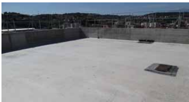
Struttura in calcestruzzo
