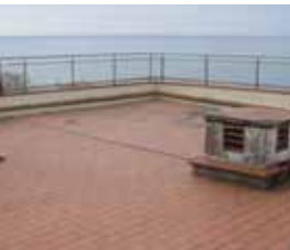
Preparazione del supporto
