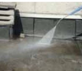
Pulizia del supporto
