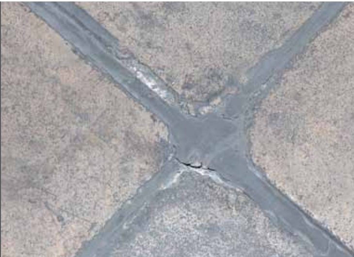
foto 19 Esempio di degrado su giunti
