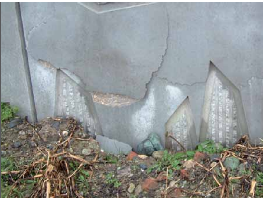
foto 14 Degrado dovuto al gelo
