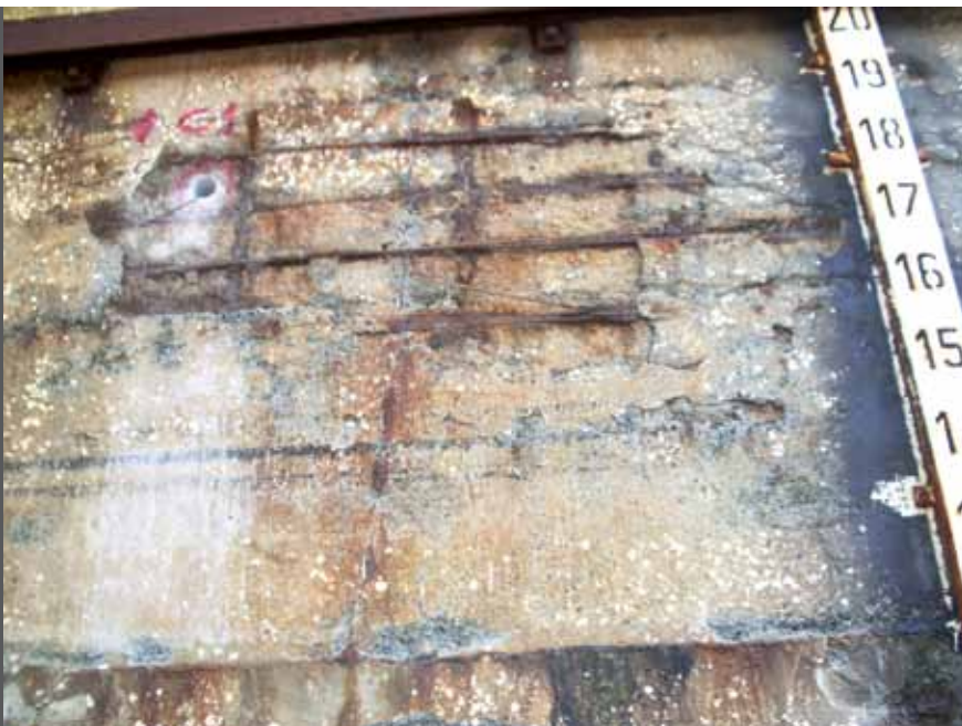
foto 10 Corrosione dovuta all'attacco da cloruri
