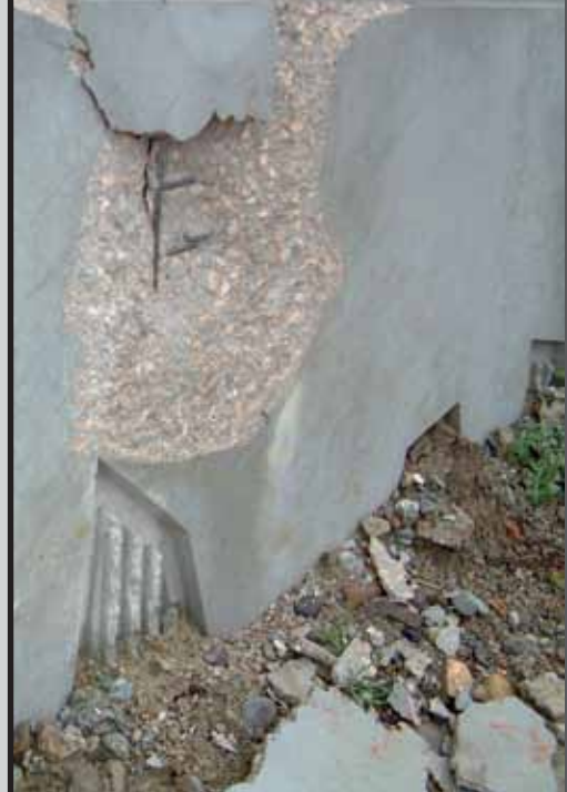
foto 15 Degrado dovuto al gelo
