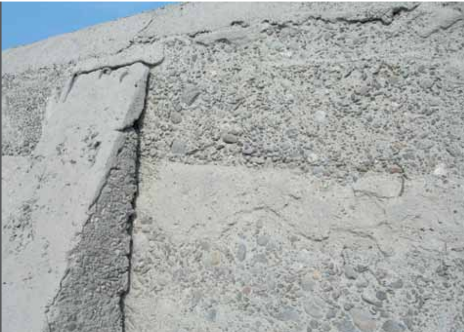
foto 5 Effetto del dilavamento su una superficie in calcestruzzo
