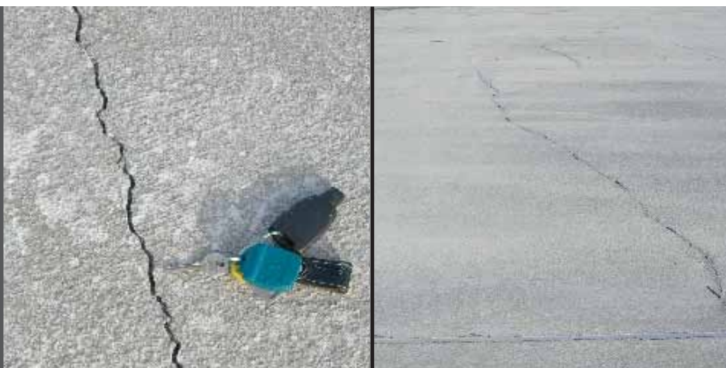
foto 16 Fessurazione di calcestruzzo
