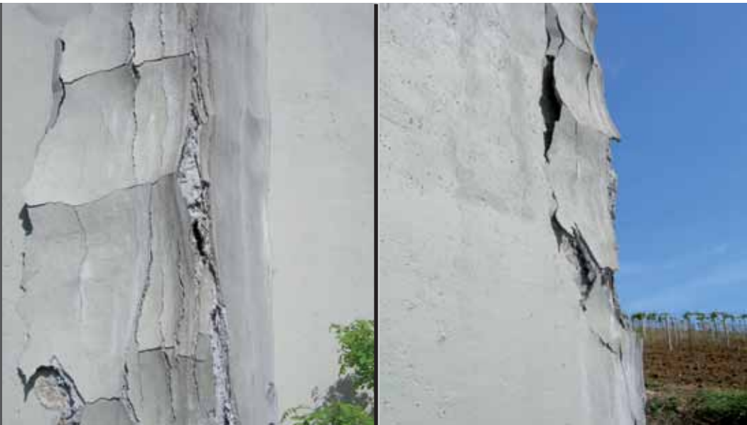
foto 7/8 Esempio di struttura interessata da aggressione solfatica
