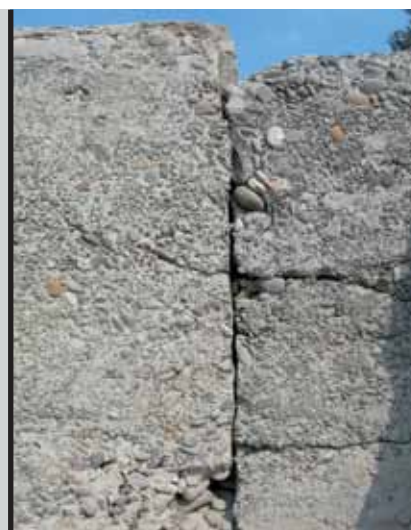
foto 18 Esempio di erosione
