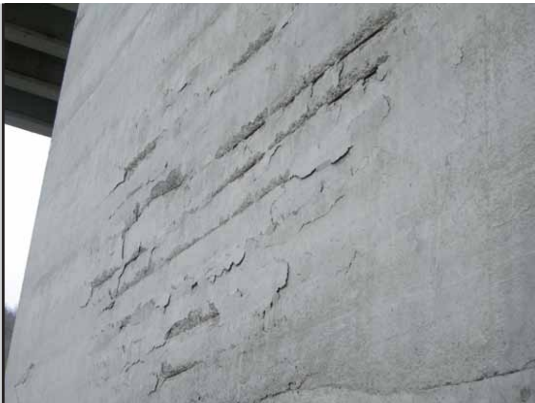
foto 4 Struttura degradata a causa della corrosione dei ferri
