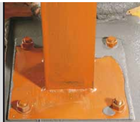
foto 13 Inghisaggio di una piastra metallica con MAPEFILL
