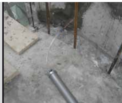
foto 18 Ancoraggio realizzato con EPOJET
