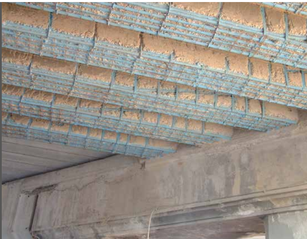
foto 13 Ferri d'armatura di travi da ponte trattati con MAPEFER 1K , protettivo anticorrosione
