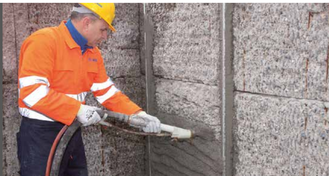
foto 6 Applicazione a spruzzo su una struttura in calcestruzzo con MAPEGROUT 430 , malta strutturale di classe R3
