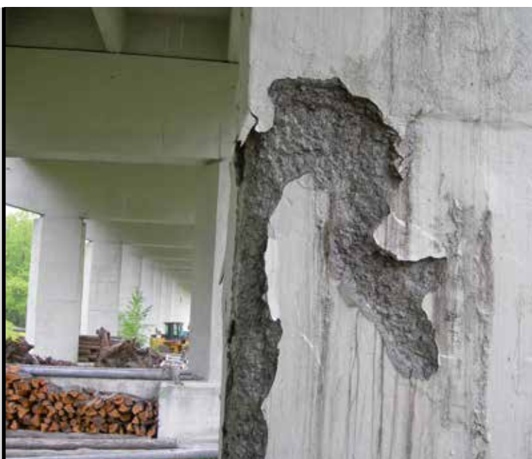
foto 1 Esempio di calcestruzzo degradato dall'attacco zolfatico
