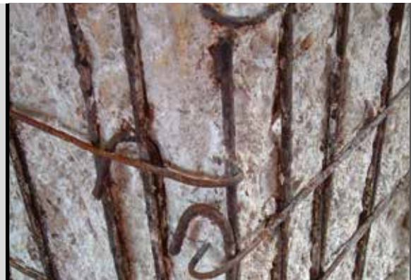
foto 2 Esempio di degrado dell'armatura del calcestruzzo causato dalla corrosione
