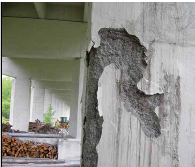
foto 1 Esempio di calcestruzzo degradato dall'attacco zolfatico
