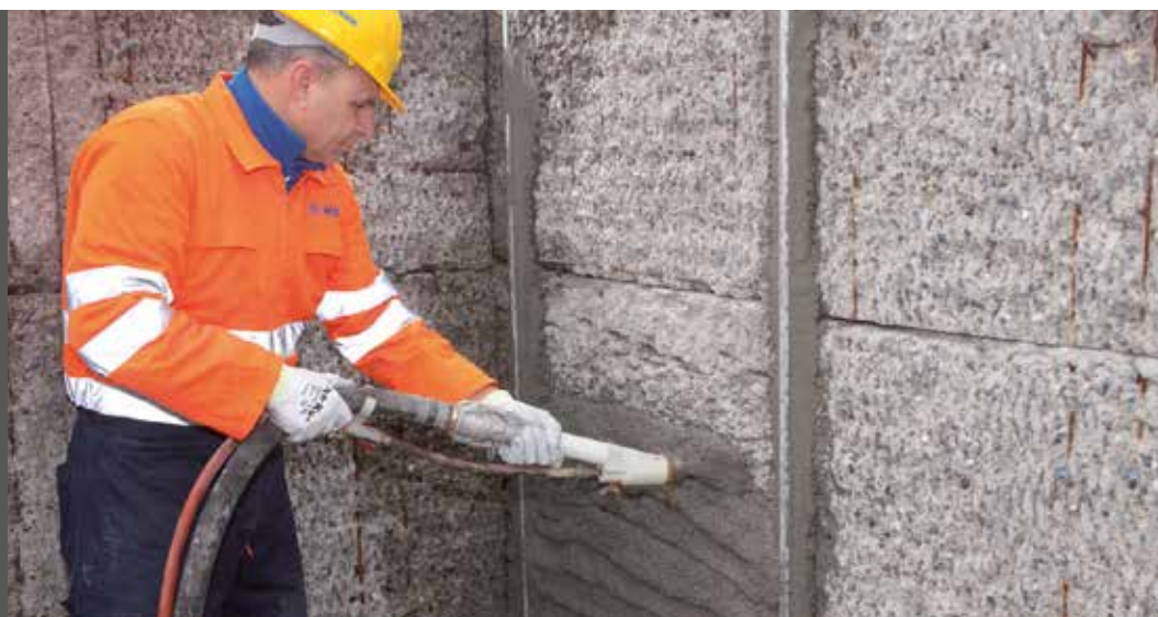
foto 6 Applicazione a spruzzo su una struttura in calcestruzzo con MAPEGROUT 430 , malta strutturale di classe R3
