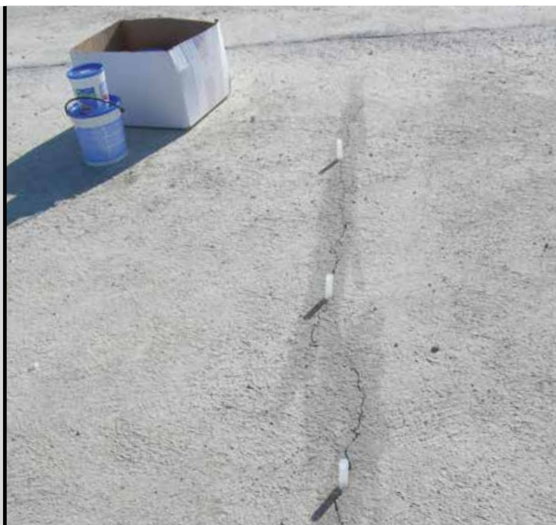
foto 11 Iniezione di EPOJET in una lastra di calcestruzzo fessurato
