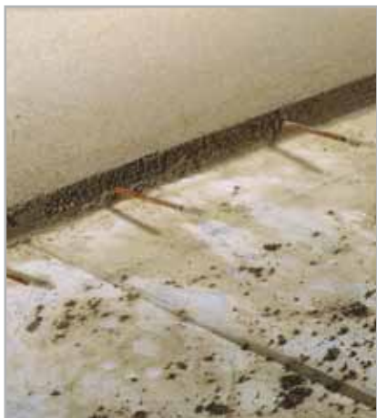
Fig. 7.2 - Taglio perpendicolare del massetto in corrispondenza del punto di interruzione
