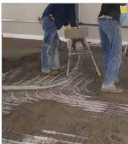
Fig. 4.7 - Realizzazione di massetto incorporante le serpentine di un impianto radiante
