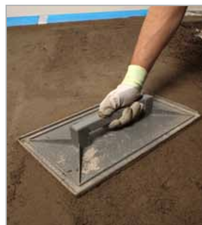
Fig. 7.6 - Finitura con frattazzo della superficie del massetto
