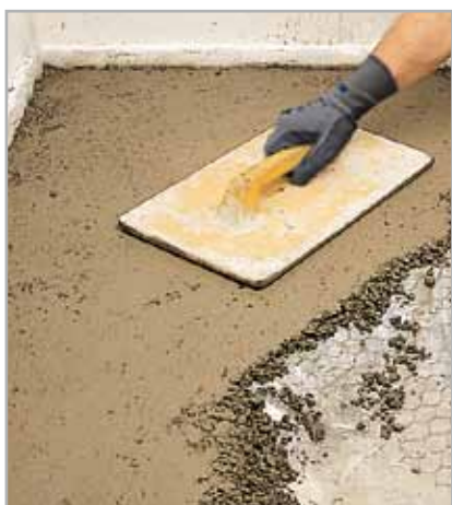
Fig. 7.4 - Armatura del massetto con rete metallica sottile in corrispondenza del passaggio di tubazioni
