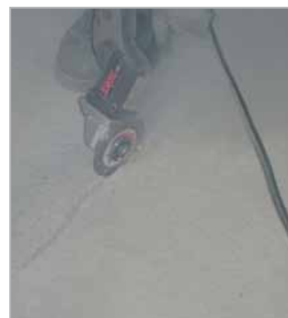
Fig. 8.2 - Apertura delle fessurazioni del massetto con flessibile
