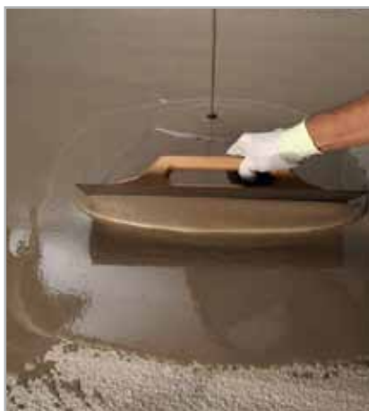
Fig. 8.14 - Regolarizzazione della planarità del massetto tramite stesura di ULTRAPLAN
