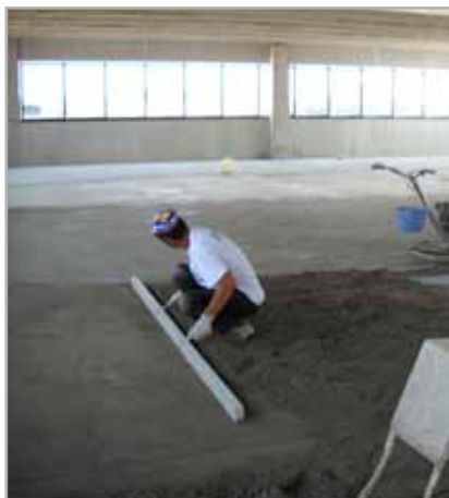
Fig. 6.3 - Staggiatura dell'impasto di TOPCEM/ TOPCEM PRONTO
