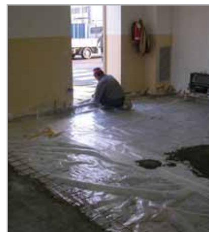
Fig. 4.2 - Realizzazione di massetto desolidarizzato su foglio di polietilene
