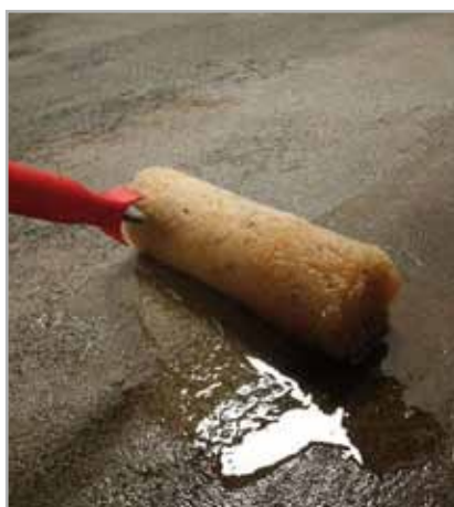
Fig. 8.11 - Applicazione di PRIMER MF sulla superficie di un massetto
