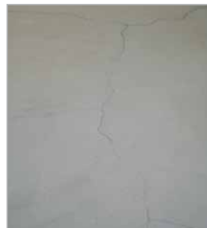
Fig. 8.1 - Massetto fessurato
