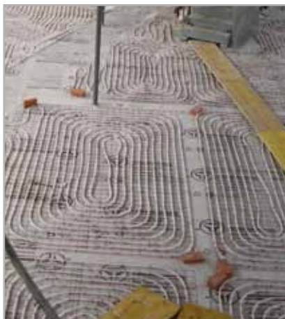
Fig. 4.6 - Predisposizione di serpentine per impianto radiante a pavimento
