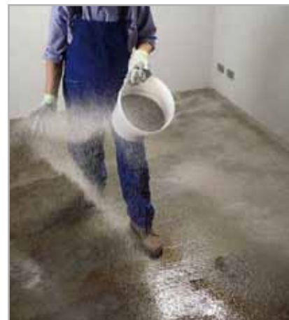
Fig. 8.12 - Spaglio di sabbia sulla superficie del massetto a seguito dell'applicazione di PRIMER MF
