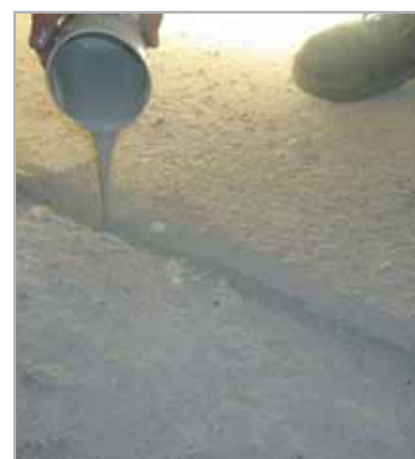
Fig. 8.3 - Sigillatura delle lesioni con EPORIP
