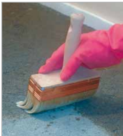
Fig. 8.13 - Applicazione a pennello sulla superficie del massetto di PRIMER G diluito con acqua
