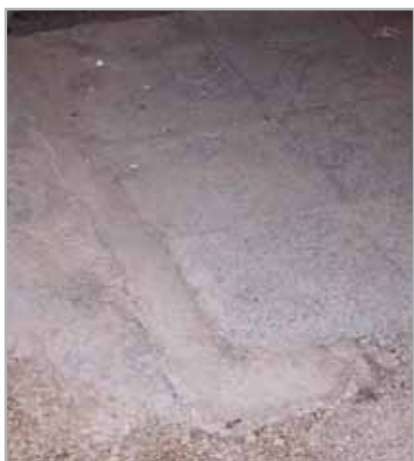
Fig. 7.3 - Sigillatura di una traccia in una pavimentazione esistente mediante applicazione di boiaccia di adesione sulle superfici di contatto tra esistente e ripristinato
