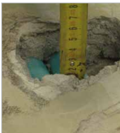
Fig. 8.6 - Spessore inadeguato di massetto sopra le tubazioni (< 3 cm)
