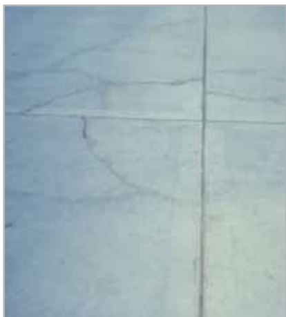
Fig. 3.3 - Dissesto da "curling" in fase avanzata
