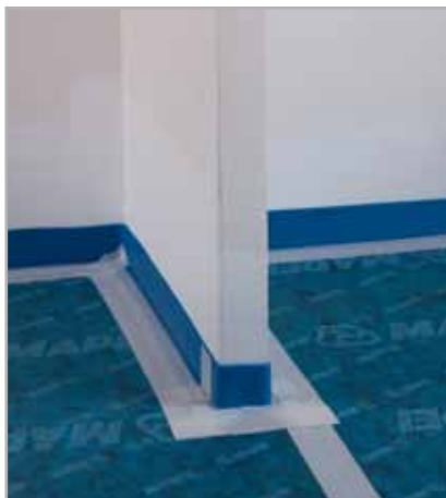
Fig. 4.9 - Solaio isolato acusticamente mediante posizionamento di MAPESILENT ROLL, MAPESILENT BAND R e MAPESILENT TAPE
