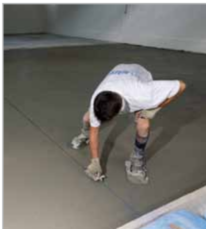
Fig. 7.8 - Realizzazione dei giunti di controllo nel massetto
