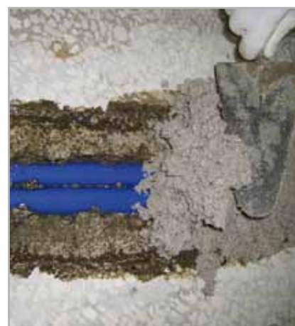
Fig. 8.8 - Riempimento della lesione con MAPEFLOOR EP19
