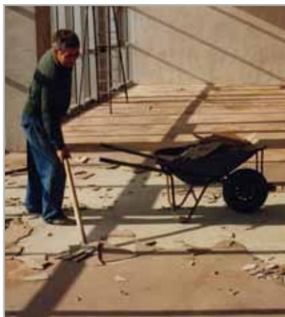
Fig. 8.10 - Distacco di ULTRAPLAN applicato su massetto con bleeding
