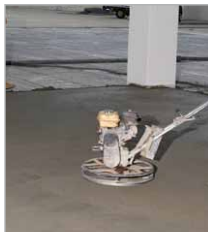
Fig. 7.7 - Finitura con disco d'acciaio della superficie del massetto
