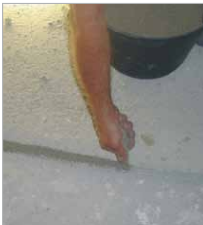
Fig. 8.4 - Applicazione di sabbia sulla superficie di EPORIP fresco
