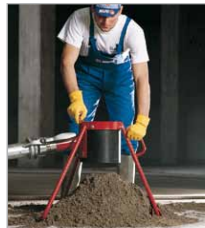
Fig. 6.2 - Alimentazione dell'impasto di TOPCEM/ TOPCEM PRONTO con pompa
