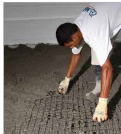
Fig. 7.5 - Posizionamento di rete metallica zincata nella mezzeria del massetto
