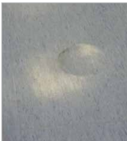
Fig. 8.5 - Sfondamento del massetto sotto la pavimentazione in corrispondenza del passaggio di tubazioni
