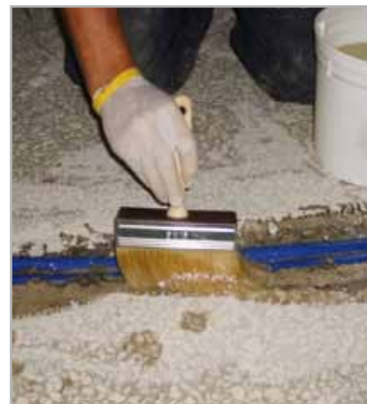
Fig. 8.7 - Applicazione di boiacca di adesione a base di resina epossidica (PRIMER MF)
