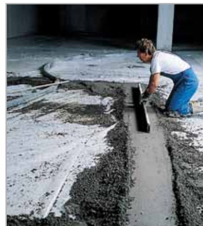
Fig. 7.1 - Formazione delle fasce di livello
