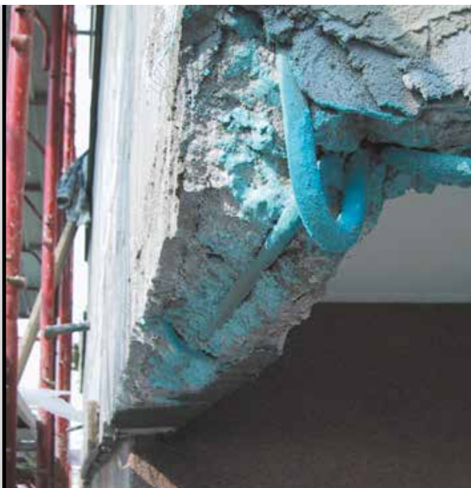
foto 3 Applicazione della malta anticorrosiva sui ferri d'armatura
