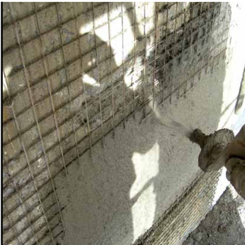
foto 7 Applicazione a spruzzo di MAPEGROUT BM
