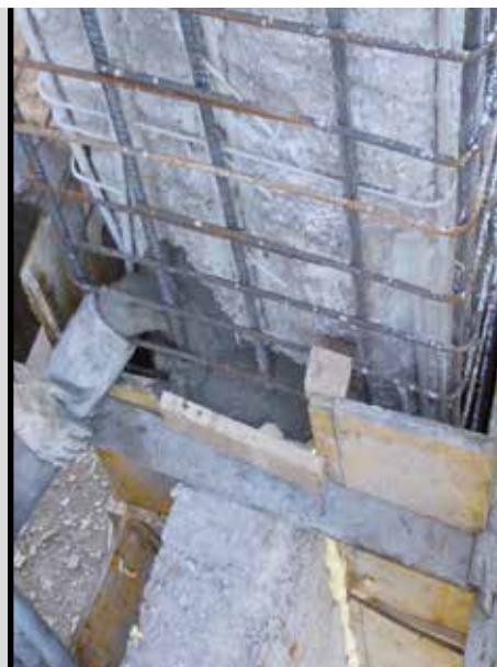
foto 12 Applicazione di MAPEGROUT GF BETONCINO B1
