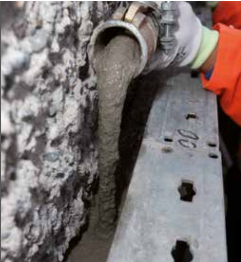
foto 11 Applicazione di MAPEGROUT COLABILE GF
