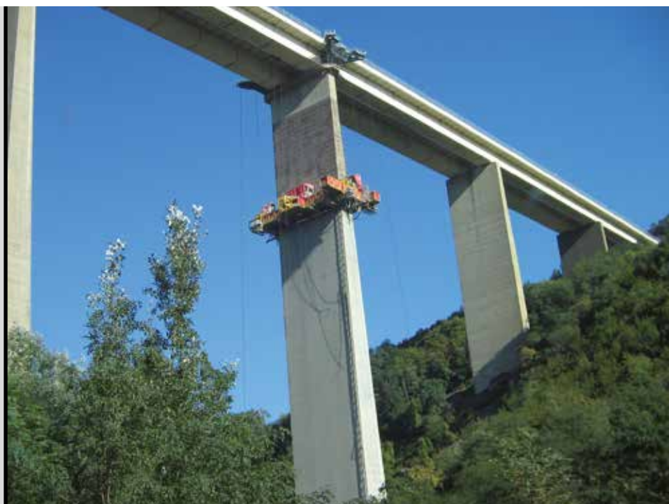
foto 2 Operazioni di idroscarifica su una pila di viadotto
