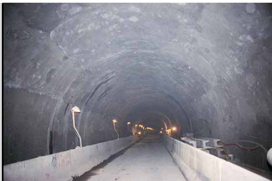
foto 6 Struttura ripristinata con MAPEGROUT T60
