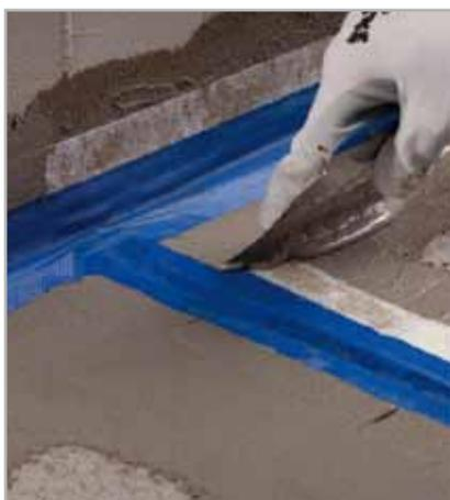
Fig. 7.8 - Dopo aver ammorsato il tessuto bianco di MAPEBAND T (pezzo speciale a T) sul prodotto fresco, stendere MAPELASTIC o MAPELASTIC SMART sul tessuto bianco di MAPEBAND
