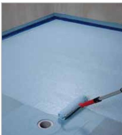
Fig. 4.18 - Applicazione, a rullo, della seconda mano di MAPELASTIC AQUADEFENSE
