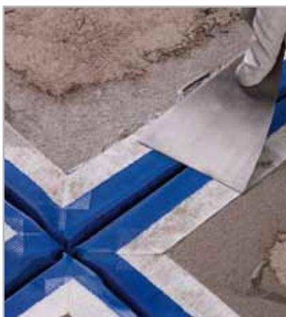
Fig. 7.9 - Ammorsamento del tessuto bianco di MAPEBAND CROSS (pezzo speciale a croce) su MAPELASTIC o MAPELASTIC SMART fresco
