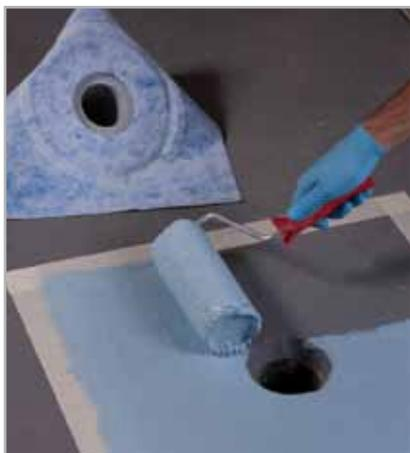
Fig. 4.16 - Stesura di MAPELASTIC AQUADEFENSE intorno allo scarico a pavimento
