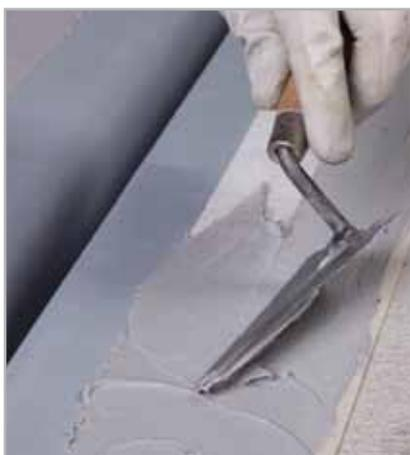
Fig. 5.44 - Dopo aver posato MAPEBAND TPE su ADESILEX PG4 fresco, stendere il secondo strato
