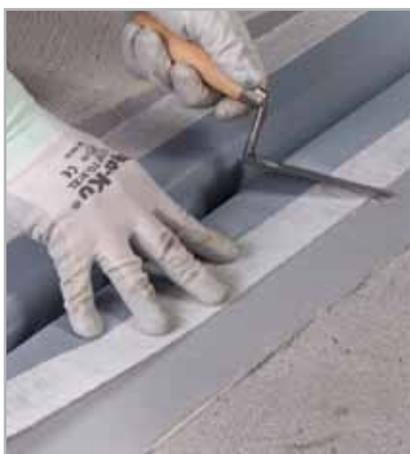
Fig. 5.15 - Posa di MAPEBAND TPE su ADESILEX PG4 fresco
