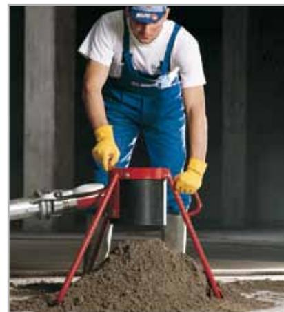
Fig. 3.7 - Stesura di TOPCEM PRONTO mediante l'impiego di apposita pompa
