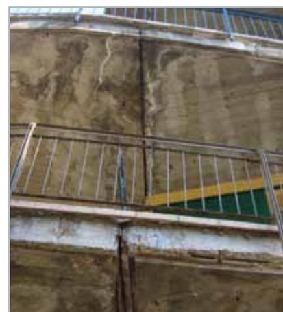
Fig. 5.3 - Giunto strutturale degradato
