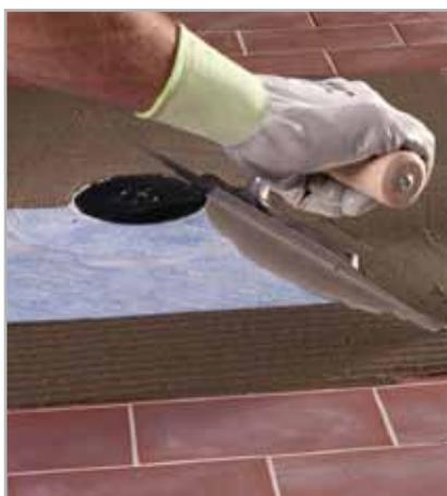
Fig. 5.9 - Stesura di MAPELASTIC o MAPELASTIC SMART sul tessuto di DRAIN VERTICAL
