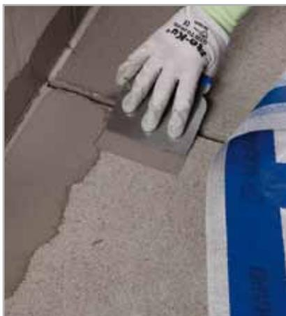
Fig. 7.7 - Stesura di MAPELASTIC o MAPELASTIC SMART in prossimità del giunto di controllo e del raccordo parete-pavimento
