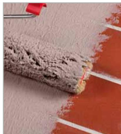
Fig. 4.2 - MAPELASTIC SMART applicato a rullo su pavimentazione esistente
