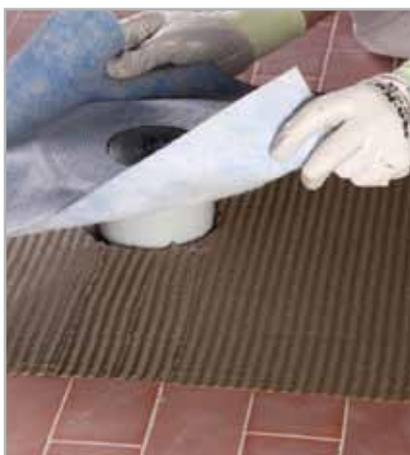
Fig. 5.8 - Applicazione di DRAIN VERTICAL su MAPELASTIC o MAPELASTIC SMART fresco
