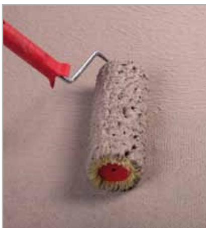
Fig. 5.51 - Stesura del secondo strato di MAPELASTIC SMART
