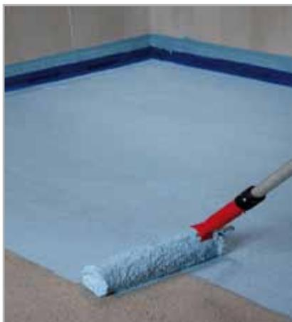
Fig. 4.4 - Applicazione della prima mano di MAPELASTIC AQUADEFENSE
