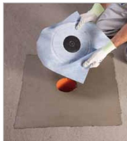
Fig. 5.59 - Posizionamento DRAIN VERTICAL
