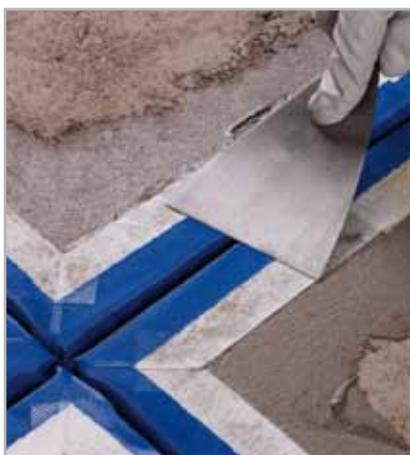
Fig. 5.68 - Ammorsamento del tessuto bianco di MAPEBAND su MAPELASTIC o MAPELASTIC SMART fresco.
