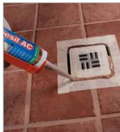
Fig. 9.2 - Sigillatura con MAPESIL AC in corrispondenza della griglia di scarico a pavimento
