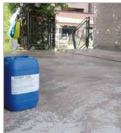
Fig. 5.30 - Stesura di PRIMER 3296 per consolidare il massetto con leggero spolvero superficiale
