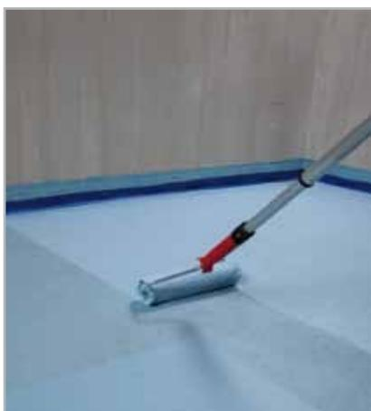
Fig. 5.57 - Applicazione, a rullo, della seconda mano di MAPELASTIC AQUADEFENSE
