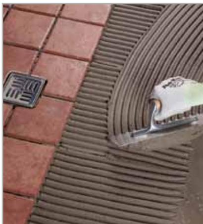
Fig. 8.4 - Incollaggio delle piastrelle su MAPELASTIC o MAPELASTIC SMART perfettamente asciutto, impiegando un adesivo di classe C2
