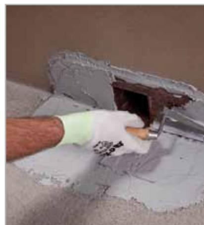
Fig. 7.5 - Stesura di ADESILEX PG4 a completo ricoprimento di DRAIN FRONT
