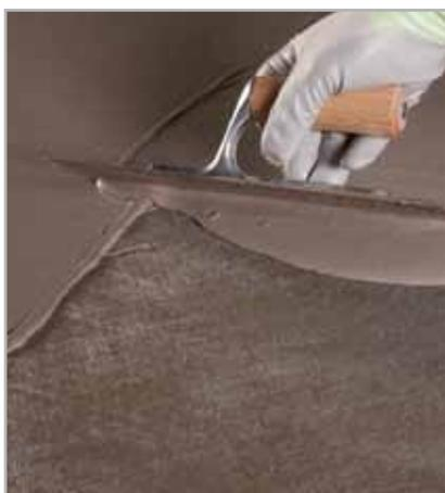
Fig. 5.21 - Stesura del secondo strato di MAPELASTIC SMART
