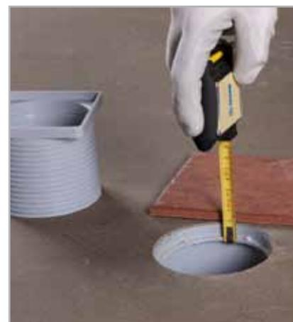
Fig. 8.1 - Misurazione della quota necessaria a posizionare lo scarico a pavimento a livello con la pavimentazione finita
