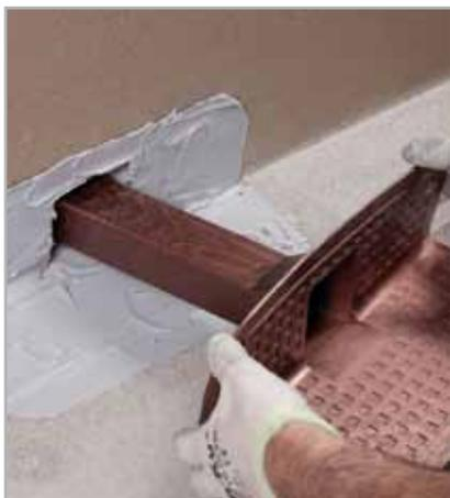
Fig. 5.37 - Applicazione di DRAIN FRONT su ADESILEX PG4 fresco
