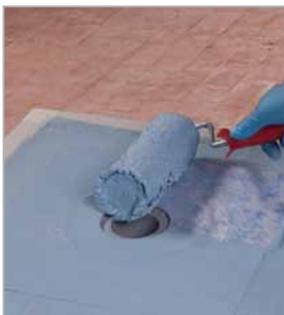
Fig. 5.26 - Copertura totale del tessuto non tessuto di DRAIN VERTICAL con MAPELASTIC AQUADEFENSE
