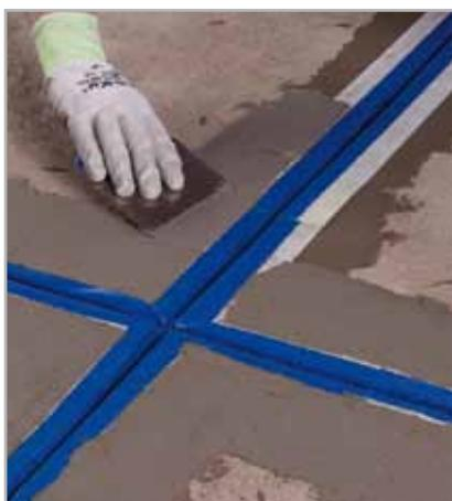
Fig. 5.69 - Stesura di MAPELASTIC o MAPELASTIC SMART sul tessuto bianco di MAPEBAND
