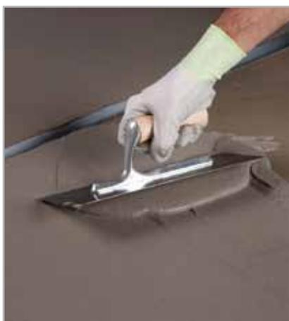
Fig. 7.15 - Stesura della seconda mano di MAPELASTIC
