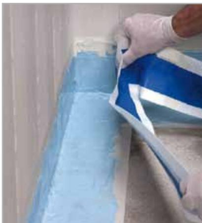
Fig. 5.55 - Applicazione di MAPEBAND su MAPELASTIC AQUADEFENSE fresco
