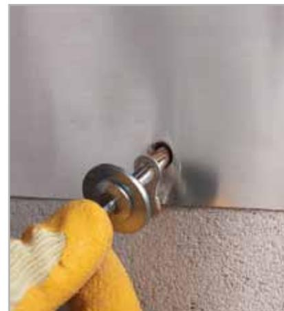
Fig. 6.7 - Fissaggio meccanico delle connessioni metalliche su MAPESHIELD E 25
