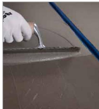
5.72 - Stesura della seconda mano di MAPELASTIC evitando di introdurlo all'interno del giunto di controllo
