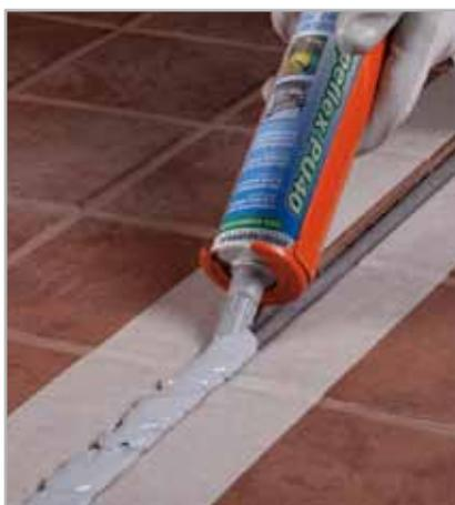
Fig. 9.5 - Sigillatura del giunto strutturale con MAPEFLEX PU40
