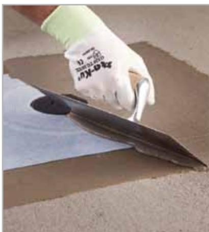
Fig. 5.62 - Stesura di MAPELASTIC o MAPELASTIC SMART sul tessuto di DRAIN VERTICAL
