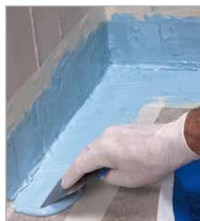
7.18 MAPELASTIC AQUADEFENSE applicato nel raccordo parete-pavimento, prima di posare MAPEBAND
