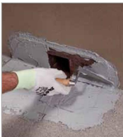
Fig. 5.38 - Stesura di ADESILEX PG4 a completo ricoprimento di DRAIN FRONT
