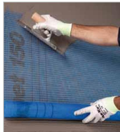
Fig. 4.1 - Applicazione di MAPELASTIC, armato con MAPENET 150, su supporto con cavillature
