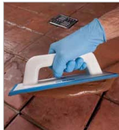
Fig. 9.1 - Stuccatura delle fughe
