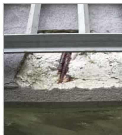
Fig. 6.2 - Frontalino degradato di un balcone
