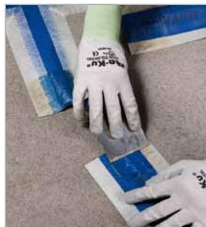
Fig. 5.41 - Spalmatura di ADESILEX LP su MAPEBAND
