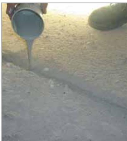
Fig. 5.32 - Sigillatura delle lesioni con EPORIP
