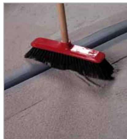
Fig. 5.18 - Rimozione del quarzo non adesivo a reticolazione completata di ADESILEX PG4
