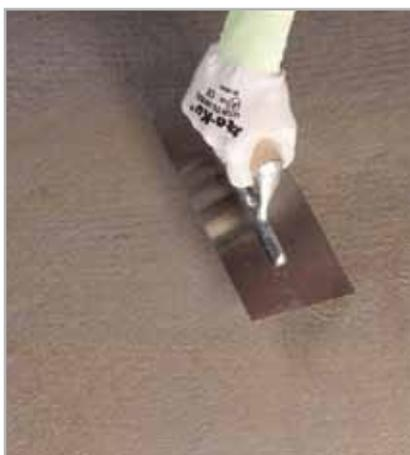
Fig. 5.20 - Ammorsamento di MAPETEX SEL nel primo strato di MAPELASTIC SMART
