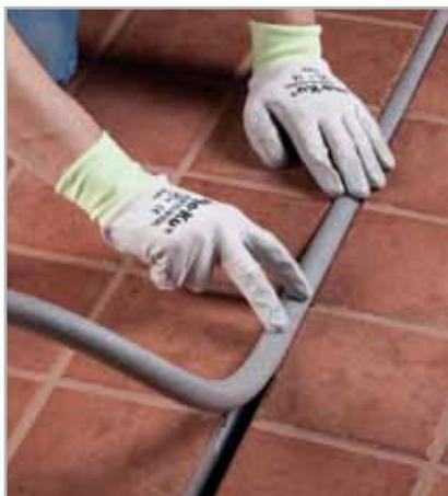
Fig. 9.4 - Inserimento del cordoncino MAPEFOAM all'interno del giunto strutturale per regolare lo spessore di MAPEFLEX PU40
