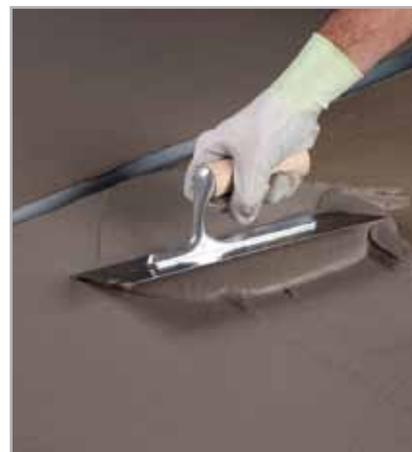
Fig. 5.48 - Stesura della seconda mano di MAPELASTIC
