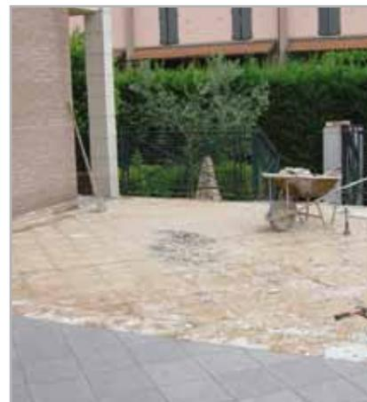
Fig. 5.28 - Rimozione della pavimentazione non adesa al supporto
