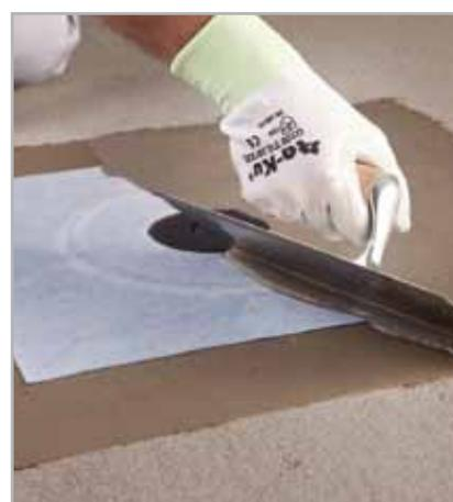
Fig. 5.36 - Stesura di MAPELASTIC o MAPELASTIC SMART sul tessuto di DRAIN VERTICAL
