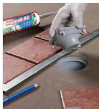
Fig. 8.3 - Incollaggio della prolunga telescopica porta-griglia (con tappo anti-odore inserito), con solo quattro punti di sigillante silicnico MAPESIL AC
