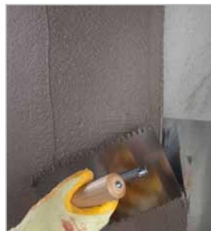
Fig. 6.8 - Protezione e regolarizzazione della superficie con MAPELASTIC
