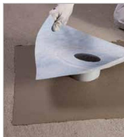
Fig. 5.35 - Applicazione di DRAIN VERTICAL su MAPELASTIC o MAPELASTIC SMART fresco
