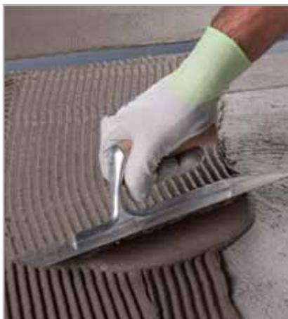
Fig. 7.13 - Stesura della prima mano di MAPELASTIC partendo dal giunto strutturale
