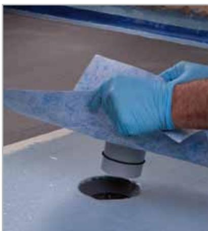
Fig. 4.17 - Applicazione di DRAIN VERTICAL su MAPELASTIC AQUADEFENSE fresco
