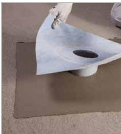
Fig. 7.2 - Applicazione di DRAIN VERTICAL su MAPELASTIC o MAPELASTIC SMART fresco
