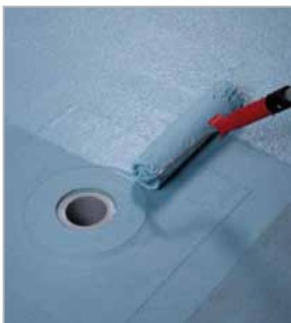
Fig. 5.27 - Applicazione, a rullo, della seconda mano di MAPELASTIC AQUADEFENSE
