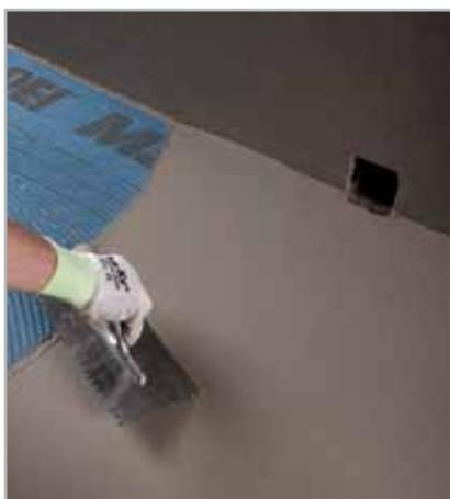
Fig. 5.50 - Ammorsamento di MAPENET 150 nel primo strato fresco di MAPELASTIC
