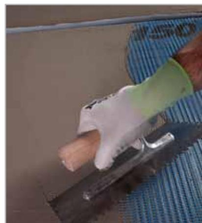
Fig. 5.47 - Ammorsamento di MAPENET 150 nel primo strato fresco di MAPELASTIC
