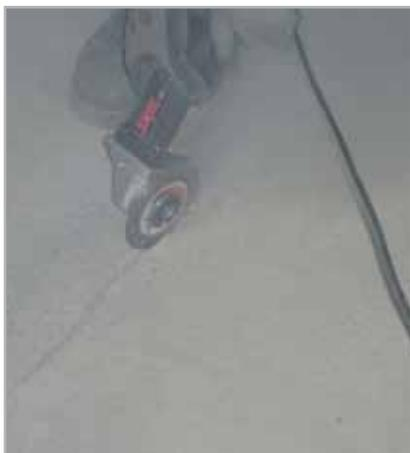
Fig. 5.31 - Apertura con flessibile delle fessurazioni sul massetto
