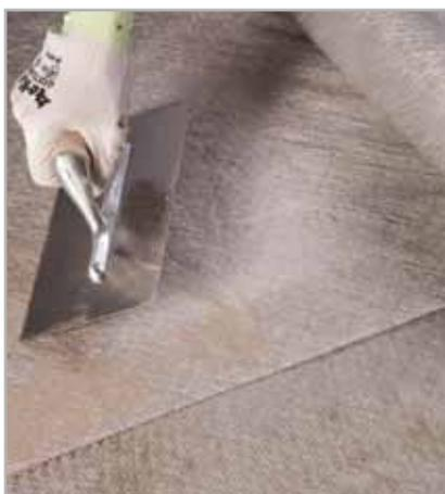
5.74 - Ammorsamento di MAPETEX SEL nel primo strato fresco di MAPELASTIC SMART
