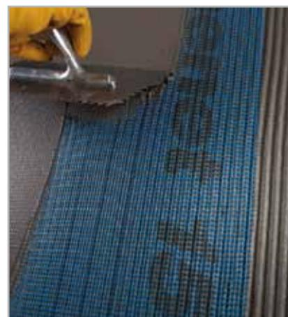
Fig. 6.9 - Ammorsamento di MAPENET 150 nel primo strato fresco di MAPELASTIC
