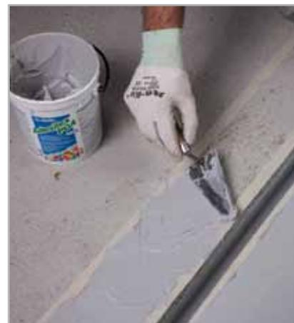
Fig. 7.10 - Stesura del primo strato di ADESILEX PG4
