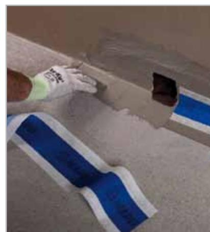
Fig. 5.66 - Stesura di MAPELASTIC o MAPELASTIC SMART nel raccordo parete-pavimento in prossimità di DRAIN FRONT, per applicare MAPEBAND
