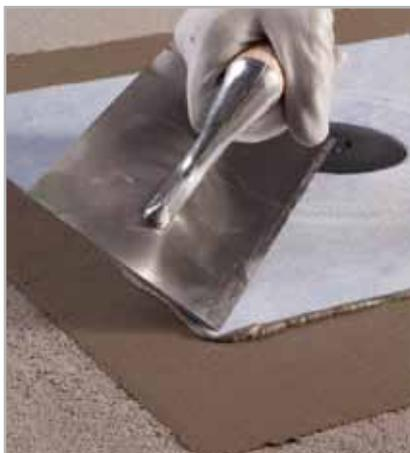
Fig. 5.61 - Premere il tessuto non tessuto di DRAIN VERTICAL su MAPELASTIC o MAPELASTIC SMART
