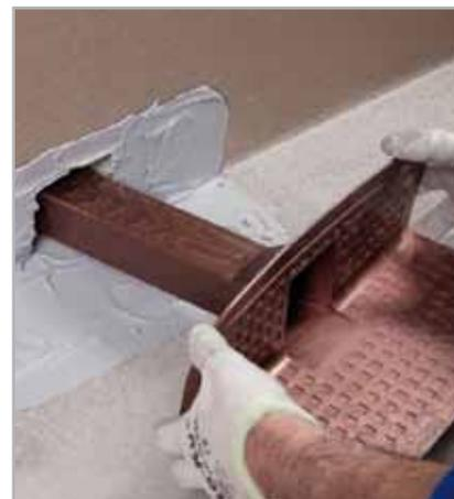
Fig. 5.64 - Applicazione di DRAIN FRONT su ADESILEX PG4 fresco
