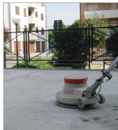
Fig. 5.29 - Carteggiatura del supporto per eliminare la colla indurita presente sul massetto
