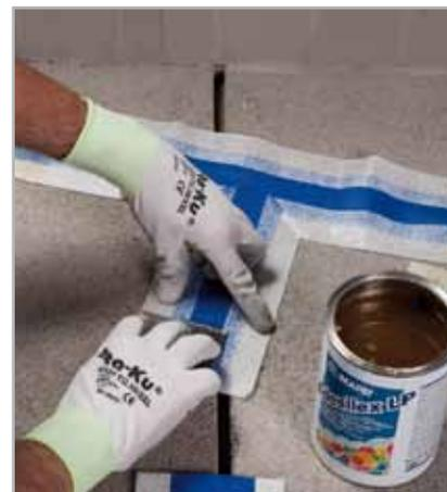
Fig. 5.40 - Spalmatura di ADESILEX LP su MAPEBAND T
