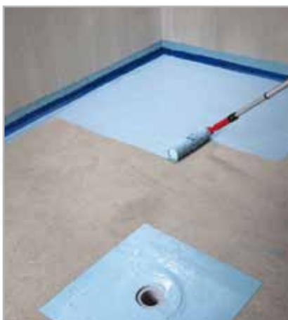
Fig. 5.56 - Applicazione, a rullo, della prima mano di MAPELASTIC AQUADEFENSE
