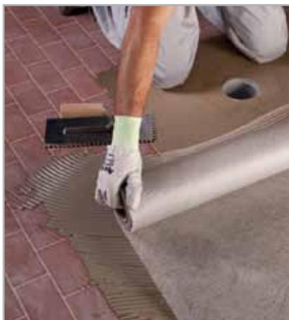
Fig. 5.19 - Stesura di MAPETEX SEL su MAPELASTIC SMART fresco
