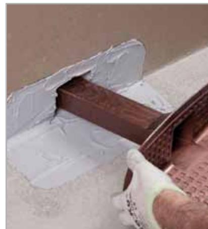
Fig. 7.4 - Applicazione di DRAIN FRONT su ADESILEX PG4 fresco
