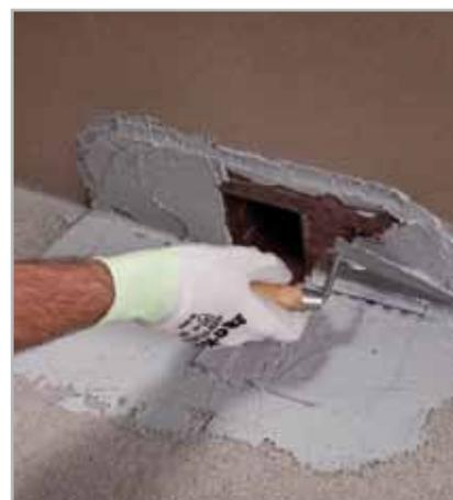
Fig. 5.65 - Stesura di ADESILEX PG4 a completo ricoprimento di DRAIN FRONT
