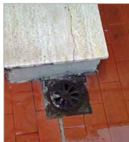
Fig. 5.2 - Scarico a pavimento con problemi di infiltrazioni
