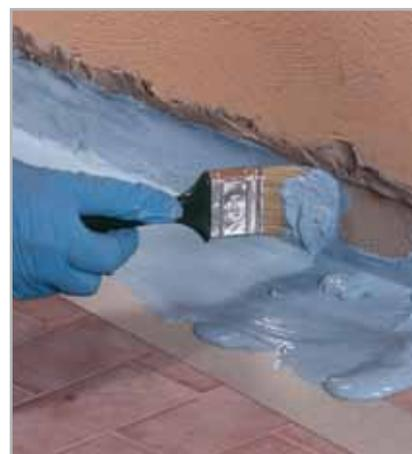
Fig. 5.24 - Stesura a pennello di MAPELASTIC AQUADEFENSE nel raccordo parete-pavimento prima di applicare MAPEBAND
