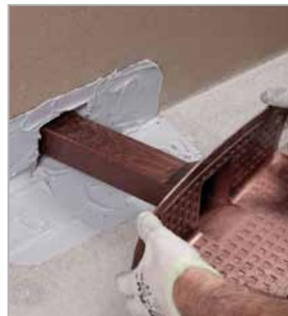
Fig. 5.10 - Applicazione di DRAIN FRONT su ADESILEX PG4 fresco
