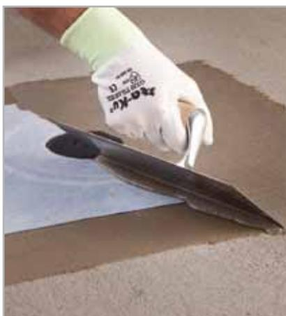
Fig. 7.3 - Stesura di MAPELASTIC o MAPELASTIC SMART sul tessuto di DRAIN VERTICAL
