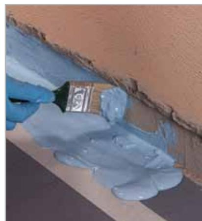
Fig. 4.15 - MAPELASTIC AQUADEFENSE steso a pennello nel raccordo parete-pavimento, prima di applicare MAPEBAND
