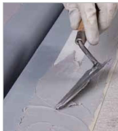
Fig. 7.11 - Dopo aver posato MAPEBAND TPE su ADESILEX PG4 fresco, stendere il secondo strato
