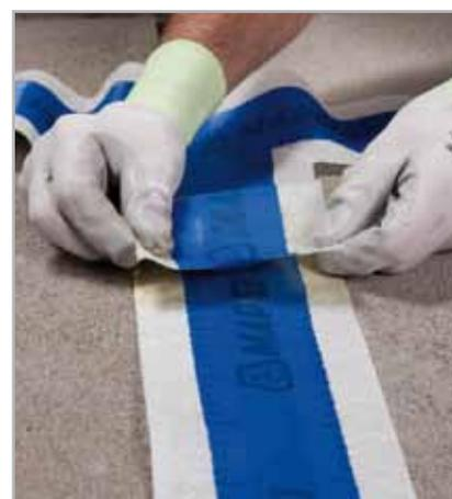
Fig. 5.42 - Incollaggio tra MAPEBAND T e MAPEBAND, sovrapponendo le estremità
