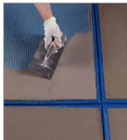
5.71 - Posa di MAPENET 150 partendo dal giunto di controllo. Successivo ammorso di MAPENET 150 nel primo strato fresco di MAPELASTIC
