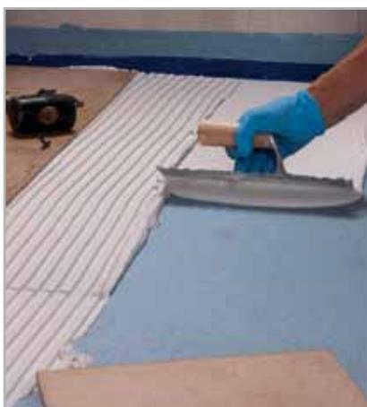
Fig. 8.6 - Incollaggio delle piastrelle su MAPELASTIC AQUADEFENSE perfettamente asciutto, impiegando un adesivo di classe C2
