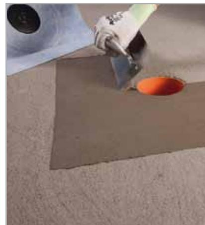
Fig. 5.34 - Stesura di MAPELASTIC o MAPELASTIC SMART intorno allo scarico a pavimento
