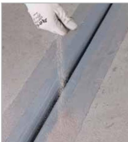
Fig. 5.45 - Spolvero di quarzo a rifiuto sul secondo strato fresco
