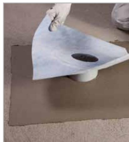
Fig. 5.60 - Inserimento nello scarico di DRAIN VERTICAL su MAPELASTIC o MAPELASTIC SMART fresco
