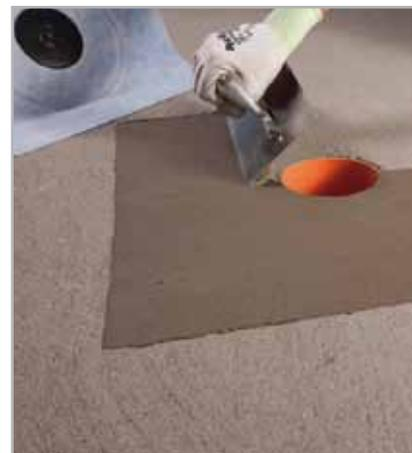
Fig. 5.58 - Stesura di MAPELASTIC o MAPELASTIC SMART intorno allo scarico a pavimento
