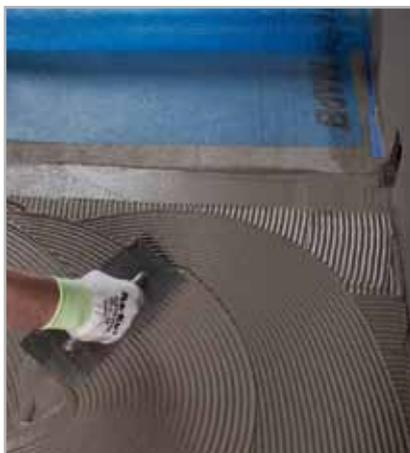
Fig. 5.49 - Stesura della prima mano di MAPELASTIC
