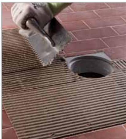
Fig. 5.7 - Stesura di MAPELASTIC o MAPELASTIC SMART intorno allo scarico a pavimento
