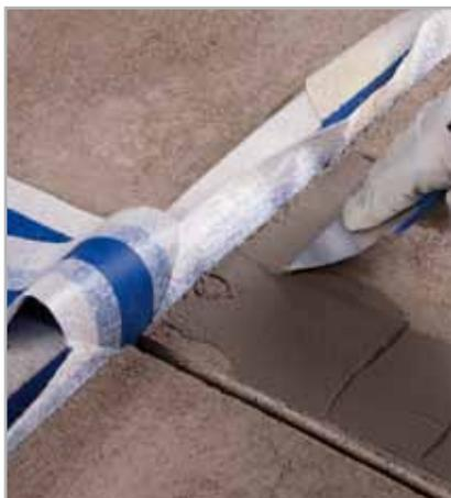
Fig. 5.67 - Inserimento di MAPEBAND CROSS ad omega rovesciata all'interno del giunto di controllo e stesura di MAPELASTIC o MAPELASTIC SMART in prossimità del giunto stesso
