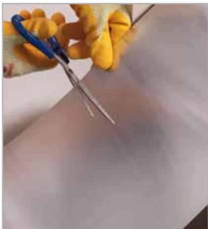
Fig. 6.4 - Taglio della lamina autoadesiva di zinco puro, MAPESHIELD E 25
