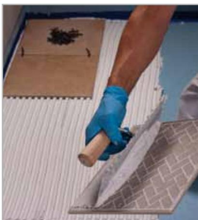
Fig. 8.5 - Stesura della colla sul retro della piastrella per evitare la formazione di vuoti al di sotto del rivestimento
