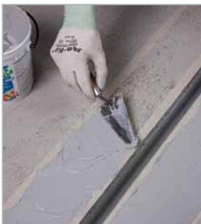
Fig. 5.14 - Stesura del primo strato di ADESILEX PG4
