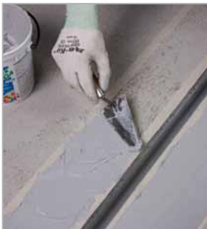
Fig. 5.43 - Stesura del primo strato di ADESILEX PG4
