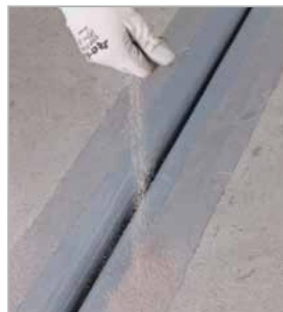
Fig. 5.17 - Spolvero di quarzo a rifiuto sul secondo strato fresco
