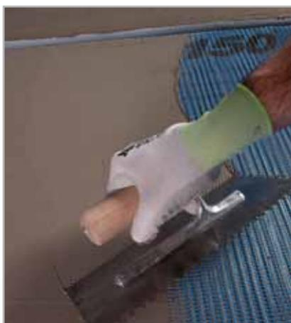
Fig. 7.14 - Ammorsamento di MAPENET 150 nel primo strato fresco di MAPELASTIC
