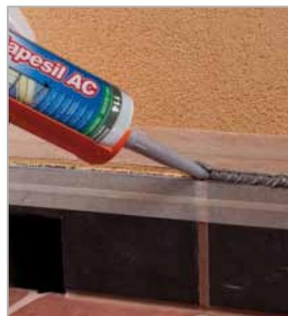
Fig. 9.3 - Sigillatura con MAPESIL AC in corrispondenza del raccordo zoccolino-parete
