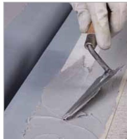
Fig. 5.16 - Stesura del secondo strato di ADESILEX PG4
