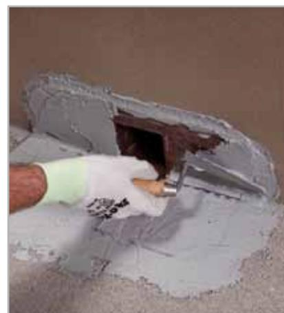
Fig. 5.11 - Stesura di ADESILEX PG4 a completo ricoprimento di DRAIN FRONT
