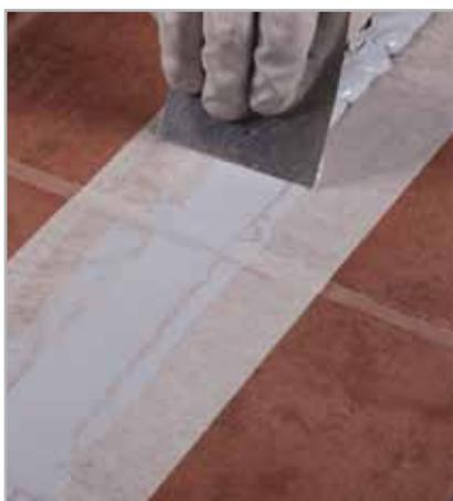
Fig. 9.6 - Lisciatura di MAPEFLEX PU40
