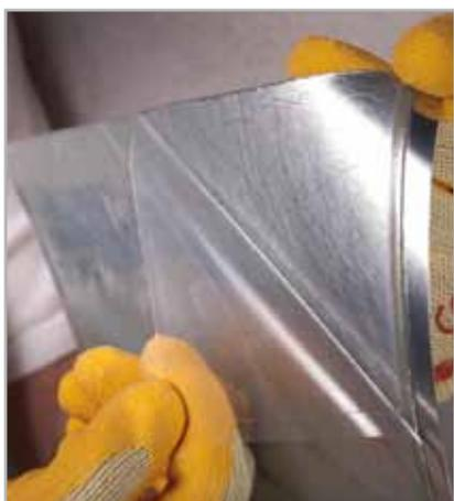
Fig. 6.5 - Rimozione del film protettivo del gel adesivo conduttore
