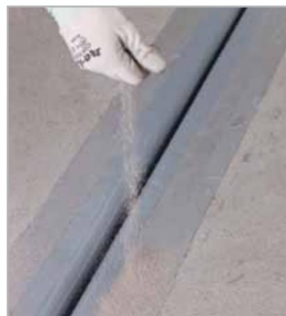
Fig. 7.12 - Spolvero di quarzo a rifiuto sul secondo strato fresco
