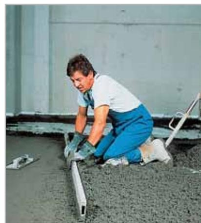
Fig. 3.8 - Staggiatura del massetto in TOPCEM PRONTO
