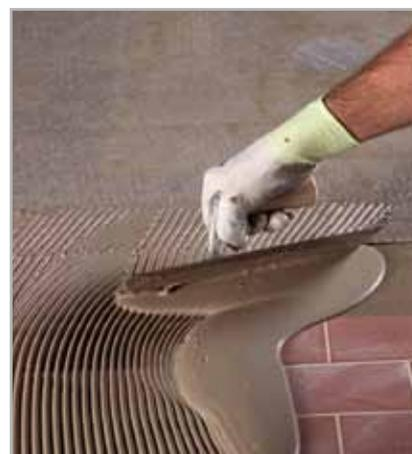
Fig. 4.3 - MAPELASTIC SMART applicato a spatola su pavimentazione esistente
