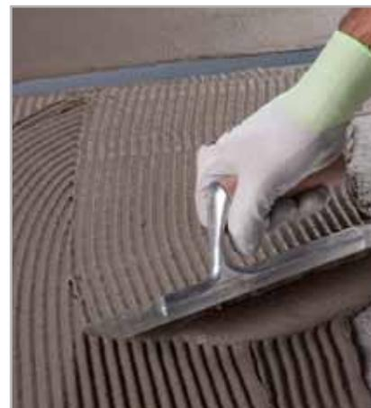
Fig. 5.46 - Stesura della prima mano di MAPELASTIC partendo dal giunto strutturale
