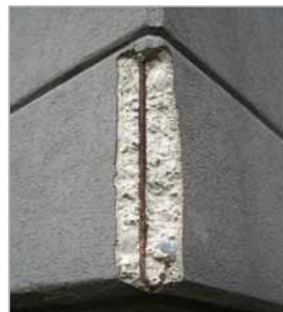
Fig. 6.1 - Espulsione dello spigolo di calcestruzzo a causa della corrosione dei ferri d'armatura
