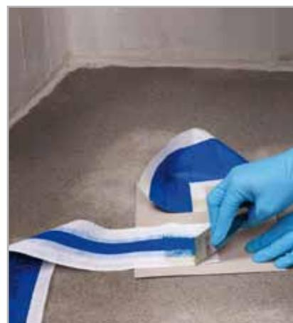
Fig. 5.54 - Spalmatura di ADESILEX LP sulle estremità di MAPEBAND e MAPEBAND ANGOLO 90°
