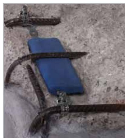
Fig. 6.3 - MAPESHIELD I applicato sui ferri d'armatura di un elemento da ripristinare
