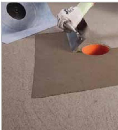
Fig. 7.1 - Stesura di MAPELASTIC o MAPELASTIC SMART intorno allo scarico a pavimento
