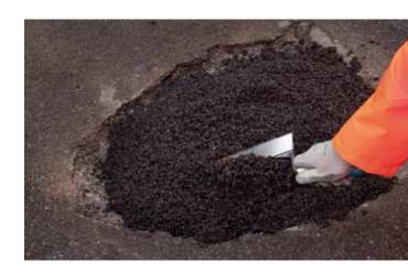
Asfalto reattivo monocomponente pronto all'uso, da applicare a freddo, per la riparazione di buche stradali.
