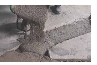
Malta colabile a ritiro compensato fibrorinforzata con fibre rigide in acciaio, a presa ed indurimento rapidi e ad elevata duttilità, per applicazioni fino a -5°C.
