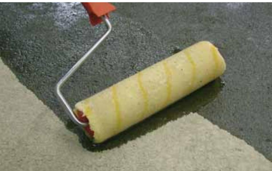
**Primer poliuretano monocomponente igroindurente, esente da solventi, a bassissima emissione di sostanze organiche volatili (VOC), per il consolidamento e l'impermeabilizzazione di massetti cementizi.**
