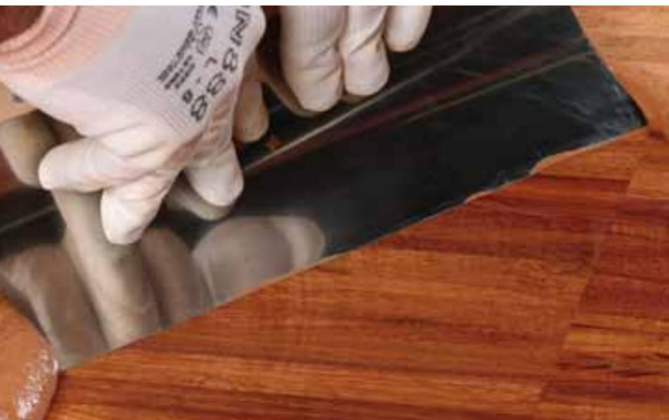
**Legante all'acqua esente da solventi e da NMP, privo di odore, da miscelare con farina di legno, per la stuccatura di pavimenti in legno. Idoneo per i cicli di verniciatura all'acqua Ultracoat ed Ultracoat Oil.**
