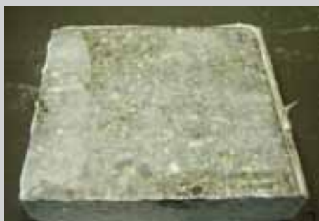
Aspetto della superficie subito dopo la stesura di Mapecrete Creme Protection
