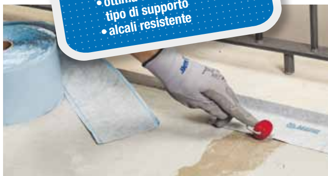
Applicazione di Mapeband SA su massetto
