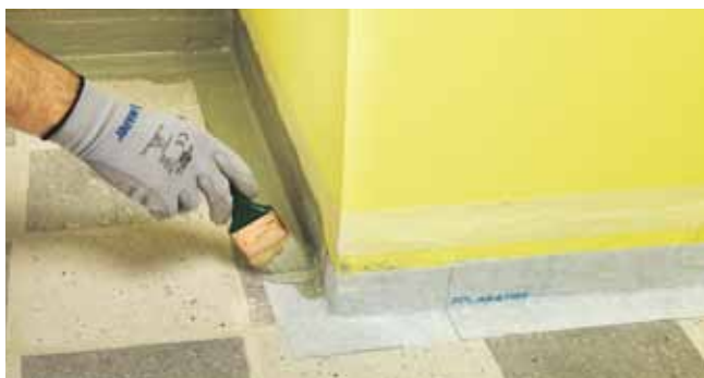
Applicazione di Mapeband SA negli spigoli
