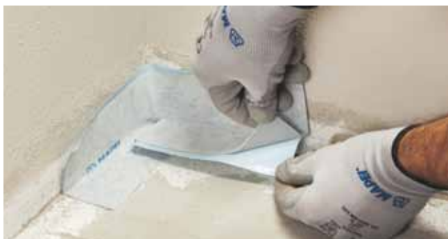
Applicazione di Mapeband SA negli angoli
