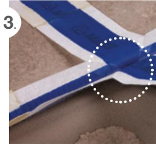
In corrispondenza dei giunti di controllo e dei raccordi tra pavimento e parete applicare **Mapeband**. La giunzione dei capi dovrà essere eseguita mediante **Adesilex LP**
