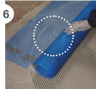
Eeguire, quindi, l'impermeabilizzazione applicando la prima mano di **Mapelastico Turbo** con interposta armatura **Mapenet 150** o **Mapetex Sel**
