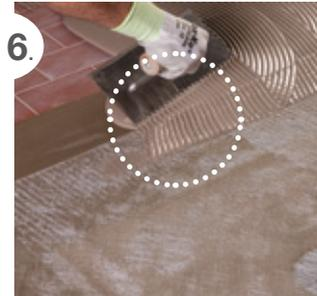
Eeguire, quindi, l'impermeabilizzazione applicando la prima mano di **Mapelastic Turbo** con interposta armatura **Mapenet 150** o **Mapetex Sel**
