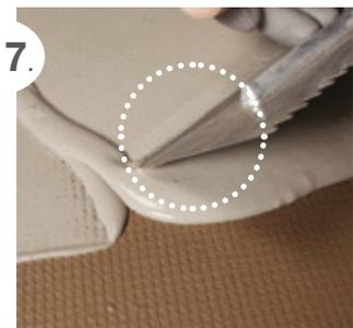
Una volta asciugata la prima mano, applicare la seconda mano di **Mapelastic Turbo**
