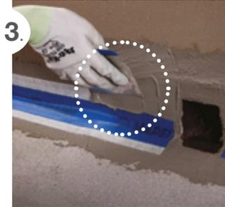
Successivamente applicare **Mapeband** nei giunti di controllo ed in corrispondenza dei raccordi pavimento/parete. La giunzione dei capi dovrà essere eseguita mediante **Adesilex LP**
