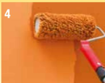
Applicazione a rullo di **Silancolor Pittura Plus** su **Mapetherm Flex RP** 0,5 mm
