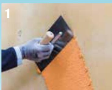
Applicazione della prima mano di **Mapetherm Flex RP**
