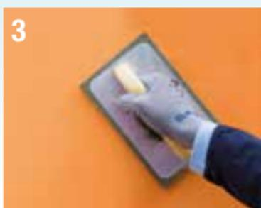
Rifinitura con frattazzino di **Mapetherm Flex RP**
