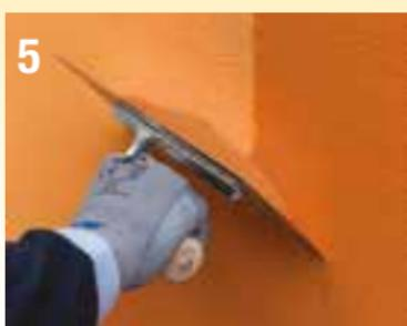
Applicazione a spatola di **Elastocolor Tonachino Plus** su **Mapetherm Flex RP** 1,5 mm
