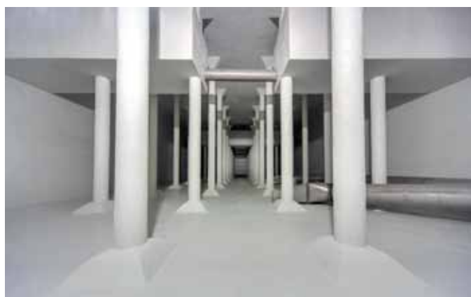
Acquedotto AP Padova Milano - Italia
