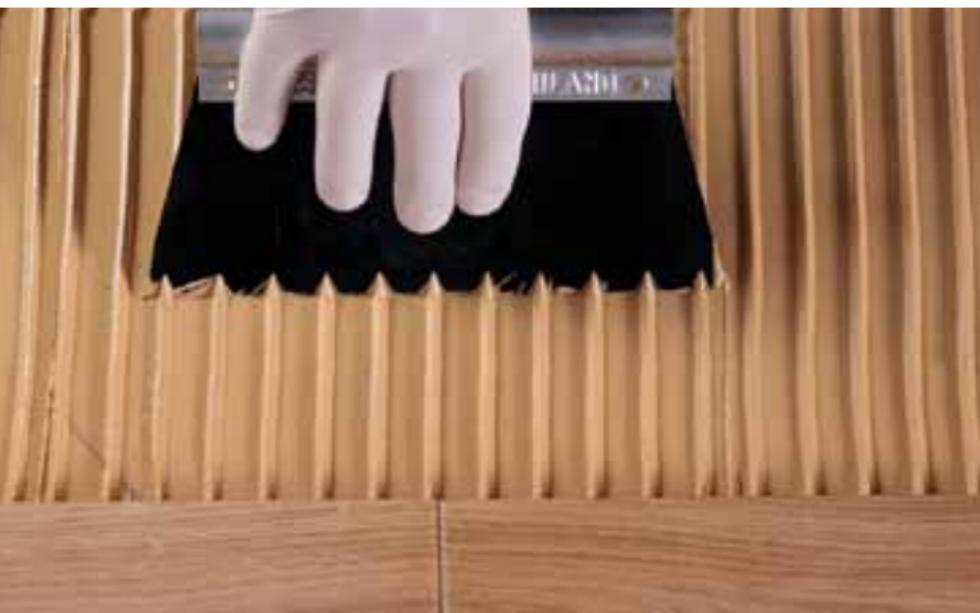
**Adesivo monocomponente poliuretano, pronto all'uso, senza solvente, per l'incollaggio del parquet prefinito multistrato.**
