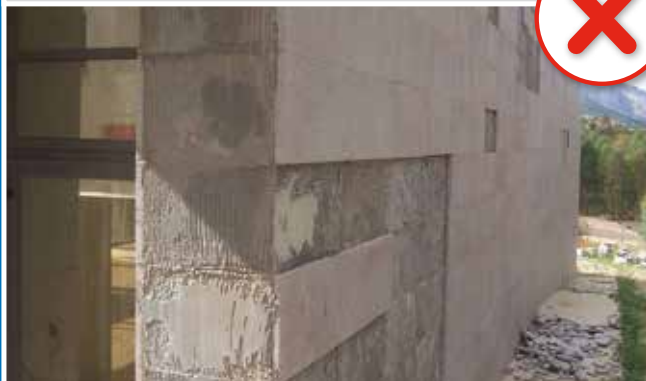
Realizzazione dei giunti non conforme alla norma
