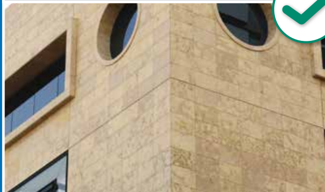
Realizzazione dei giunti conforme alla norma
