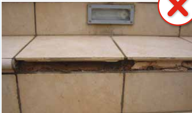
Posa non conforme a UNI 11493
