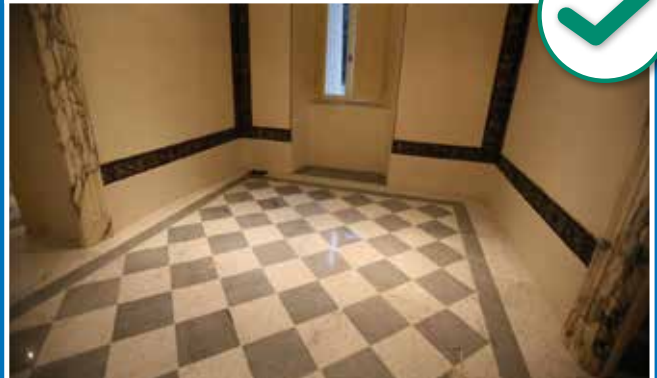
Posa su sottofondo conforme
