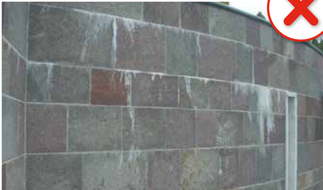
Posa su supporto non conforme
