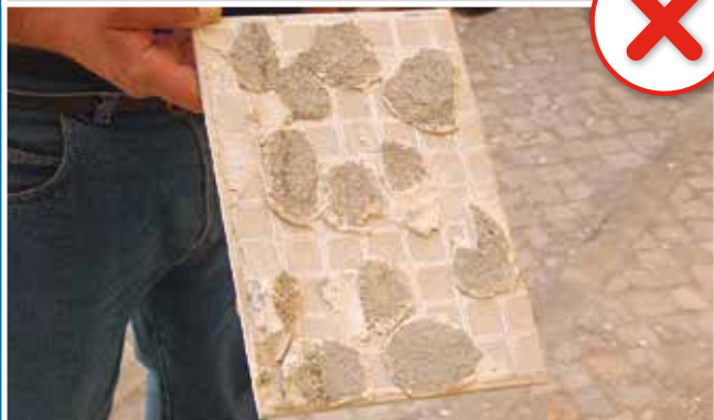
Posa non conforme a UNI 11493
