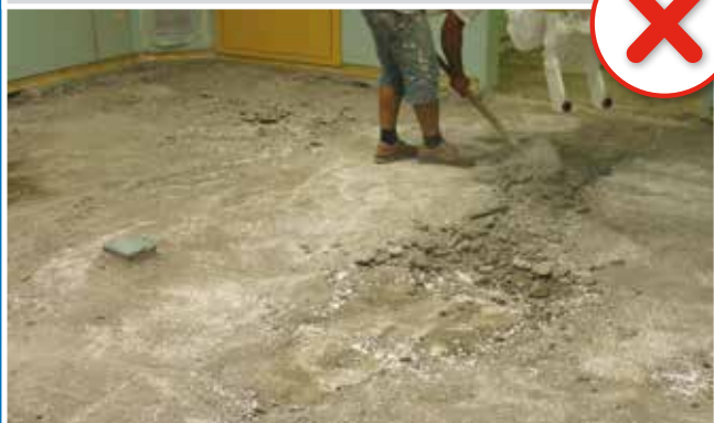
Massetto non conforme a UNI 11515
