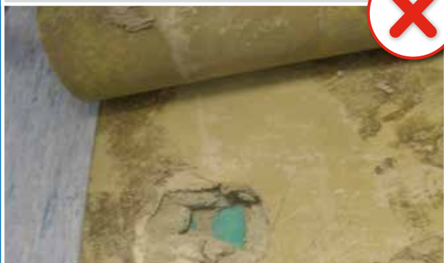
Copertura delle tubazioni non conforme a UNI 11515
