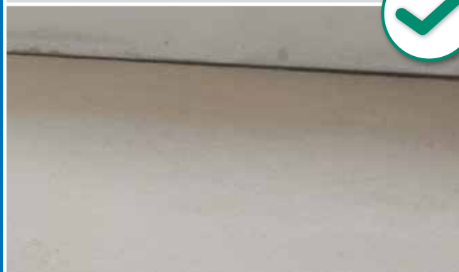
Massetto ripristinato conforme a UNI 11371
