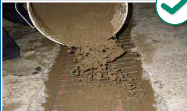
Copertura delle tubazioni conforme a UNI 11515
