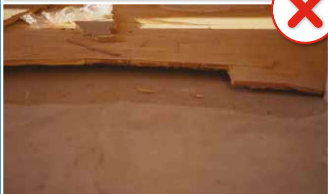
Massetto non conforme a UNI 11371
