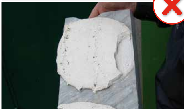
Posa non conforme
