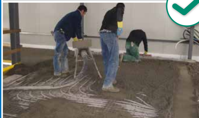
Massetto riscaldante conforme a UNI 11515
