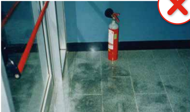
Posa su sottofondo non conforme
