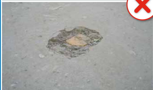
Massetto riscaldante non conforme a UNI 11515
