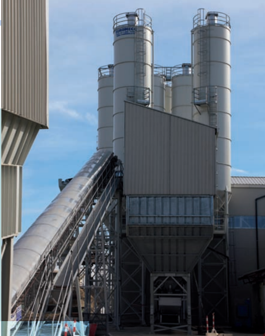
Il nuovo impianto malte di VAGA a Costa de' Nobili (PV).
