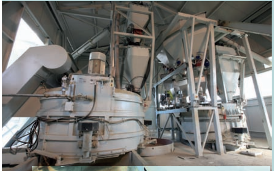
Il cuore del nuovo impianto malte a Costa de' Nobili (PV): il miscelatore.
