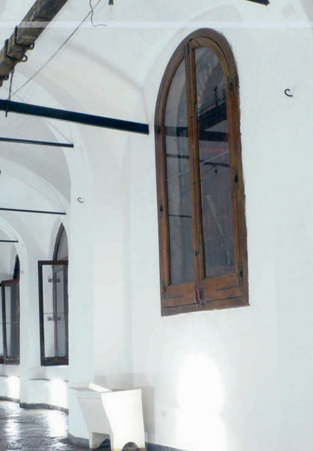
Foto 4. Sulle pareti è stato applicato SILEXCOLOR PRIMER, seguito da SILEXCOLOR PITTURA, pittura di protezione e decorazione traspirante.
