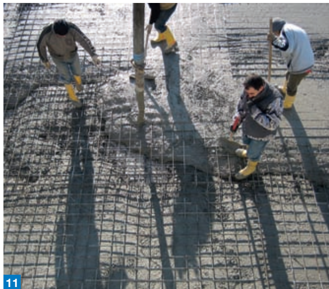
Foto 12 e 13. Il getto della platea di fondo canale dove è stata applicata la tecnologia MAPECRETE SYSTEM. Questa tecnologia è basata sul concetto di ritiro nullo del calcestruzzo, così da rendere possibile la realizzazione di grandi superfici orizzontali in calcestruzzo (dell'ordine anche di un migliaio di metri quadrati), riducendo drasticamente, o addirittura eliminando, i classici giunti di dilatazione.
