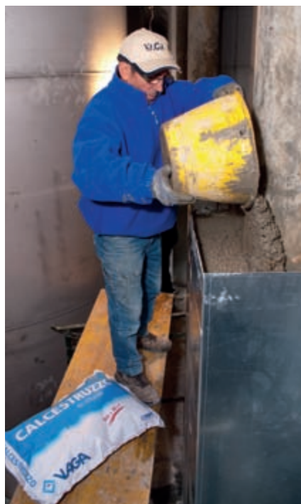
Foto 1. Particolare del cantiere della Centrale di acqua potabile di Piazzale Cantore che ne evidenzia lo spazio di lavoro limitato.
