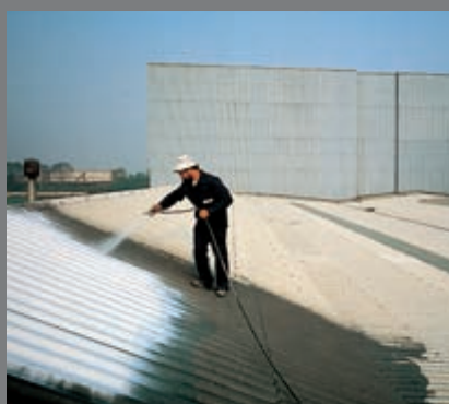
Applicazione di AQUAFLEX a spruzzo su cemento amianto ondulato trattato con PRIMER PER AQUAFLEX.
