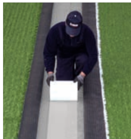
Stesura della banda di giunzione ULTRABOND TURF TAPE 100
