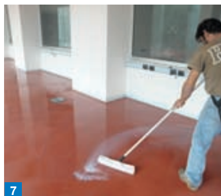
Foto 6 e 7. Per pavimentare la zona di ingresso all'edificio è stata utilizzata sempre la malta autolivellante ULTRATOP nel colore rosso.
