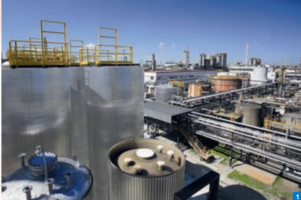
Foto 1. Linee di collegamento di apparecchiature atte a convogliare sostanze volatili al sistema di trattamento sfati nello stabilimento Vinavil di Ravenna.
