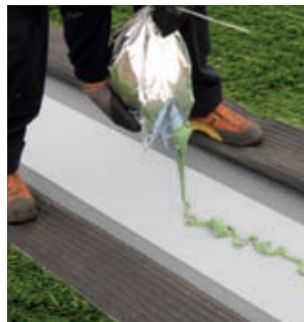
Applicazione di ULTRABOND TURF PU 1K sulla banda di giunzione mediante estrusione dal sacchetto di alluminio
