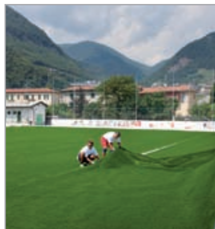
Posizionamento dei teli di erba sintetica
