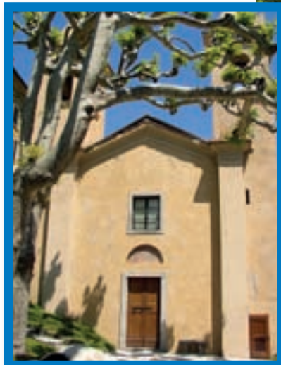
Foto 12. La merlatura delle torri e i rivestimenti della chiesa sono stati puliti e sottoposti a interventi di raschiatura parziale delle tinte. La fase finale ha visto l'applicazione di tinte ai silicati SILEXCOLOR PITTURA, previa applicazione di SILEXCOLOR PRIMER. Successiva protezione idrorepellente e incolore con ANTIPLUVIOL S. Nel riquadro, la Chiesa prima dei lavori.
