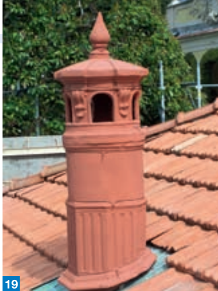
Foto 18 e 19. I camini in cotto sono stati consolidati con iniezioni di resina epossidica EPOJET e di adesivo epossidico EPORIP. La protezione finale ad azione idrorepellente è avvenuta con ANTIPLUVIOL S.
