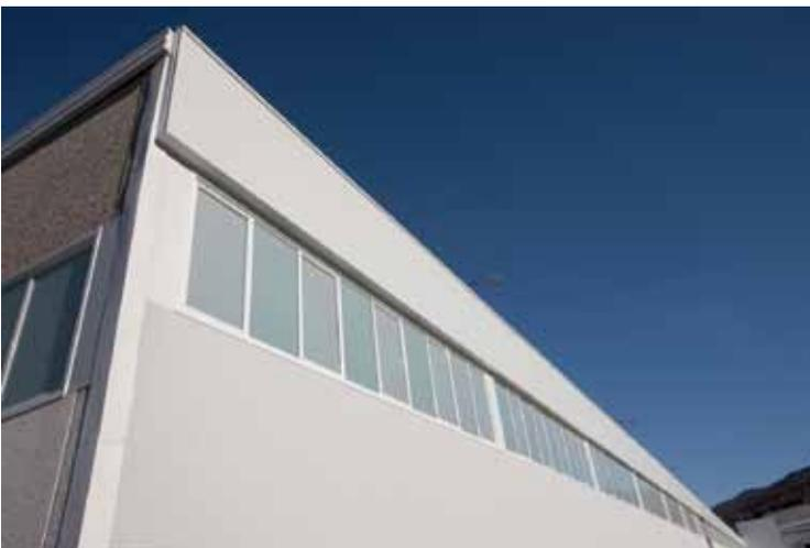
**A SINISTRA.** Una parete esterna dell'edificio è stata trattata prima con il fondo rasante elastico MAPETHERM FLEX RP e poi con la finitura ELASTOCOLOR PITTURA.
