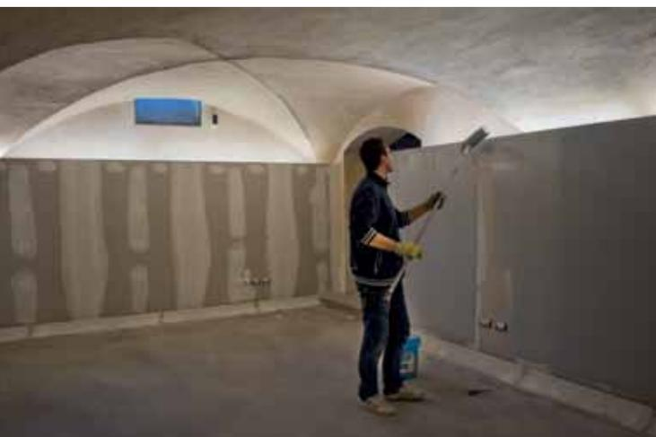
**SOPRA.** Le pareti sono state primerizzate con il fondo pigmentato QUARZOLITE BASE COAT e poi pitturate con QUARZOLITE PITTURA.
