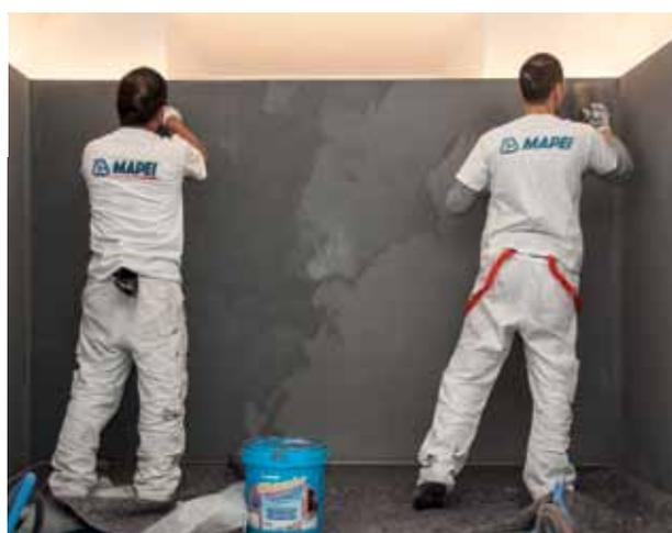
nale. Inizialmente il supporto di posa è stato primerizzato con l'appretto PRIMER SN, bicomponente a base di resine epossidiche senza solvente. Immediatamente dopo l'applicazione del primer, la superficie è stata spolverata a rifiuto con QUARZO 1:2 per consentire una perfetta adesione di ULTRATOP. La fase successiva ha visto l'applicazione della malta ULTRATOP scelta nel colore antracite.
