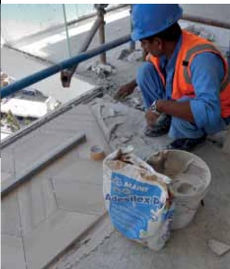
**A SINISTRA.** Le piastrelle in ceramica sono state posate con ADESILEX P9, quelle in marmo con KERAFLEX MAXI S1.
