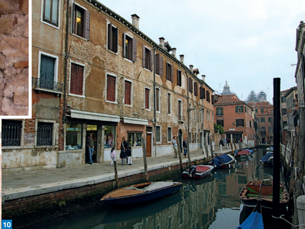
Foto 10. Un'immagine della facciata su Rio delle Torreselle prima dell'intervento di manutenzione e restauro. Nella foto piccola si nota lo stato di degrado della muratura. Foto 11. Dopo la rimozione totale del vecchio intonaco è stato applicato uno strato di MAPE-ANTIQUE RINZAFFO; si è proceduto a regolarizzare la muratura con la malta deumidificante MAPE-ANTIQUE MC. Per finire la facciata è stata trattata con il fondo SILEXCOLOR PRIMER e a suo completo asciugamento, è stato applicato sulla superficie SILEXCOLOR TONACHINO nella granulometria da 0,7 mm, utilizzato in due tonalità cromatiche, più il bianco per la fascia marcapiano.
