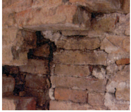
Foto 10. Un'immagine della facciata su Rio delle Torreselle prima dell'intervento di manutenzione e restauro. Nella foto piccola si nota lo stato di degrado della muratura. Foto 11. Dopo la rimozione totale del vecchio intonaco è stato applicato uno strato di MAPE-ANTIQUE RINZAFFO; si è proceduto a regolarizzare la muratura con la malta deumidificante MAPE-ANTIQUE MC. Per finire la facciata è stata trattata con il fondo SILEXCOLOR PRIMER e a suo completo asciugamento, è stato applicato sulla superficie SILEXCOLOR TONACHINO nella granulometria da 0,7 mm, utilizzato in due tonalità cromatiche, più il bianco per la fascia marcapiano.
