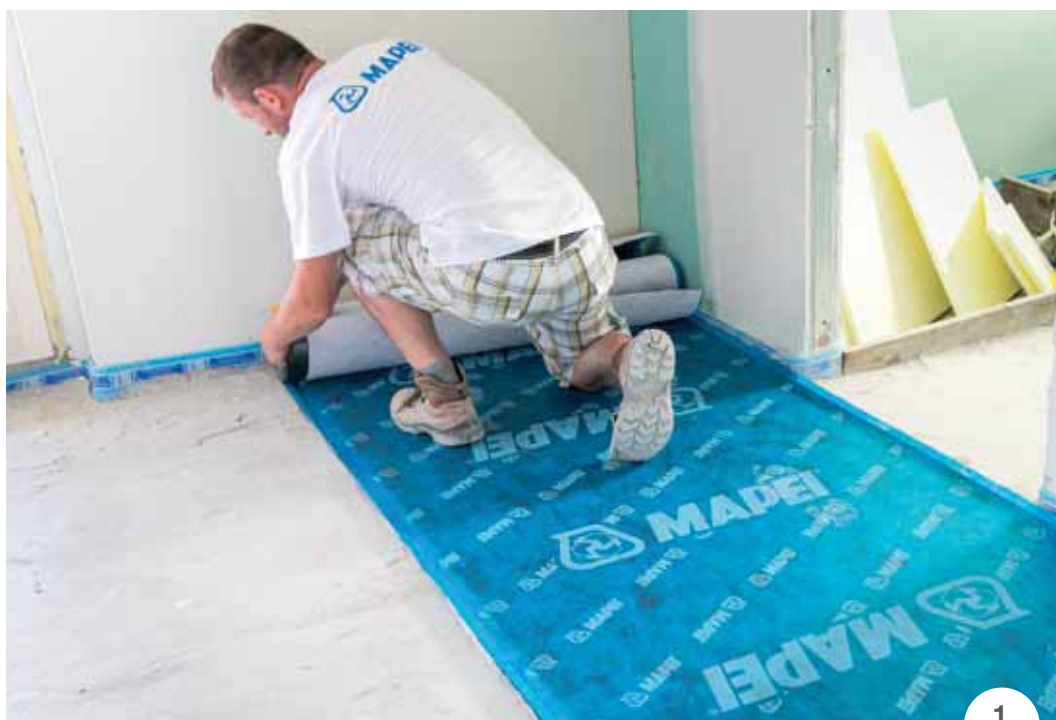
FOTO 1. Sulla superficie di calcestruzzo è stato posato lo strato di MAPESILENT ROLL con la parte fibrosa rivolta in basso.
