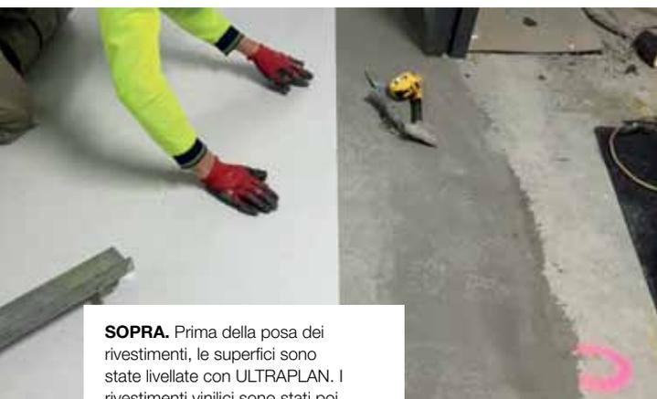
**SOPRA.** Prima della posa dei rivestimenti, le superfici sono state livellate con ULTRAPLAN. I rivestimenti vinilici sono stati poi posati con ULTRABOND ECO V4 SP.
