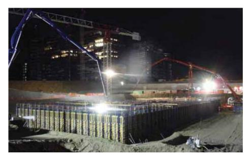
SOPRA. Il getto notturno del calcestruzzo nel 2012. SOTTO. Gli additivi DYNAMON SP1 e DYNAMON XTEND W300 sono stati utilizzati per confezionare i calcestruzzi con i quali sono stati realizzati i pilastri portanti e i solai della torre.
