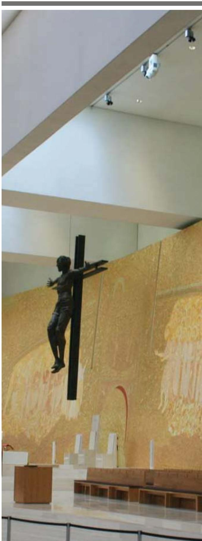
Painel realizado com Nivoplan + Planicrete, para o barramento e Kerabond + Isolastic para a colagem do mosaico de barro
