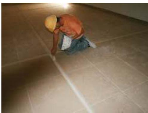
**Foto 5** - Aplicação do Mapeflex PU 30
