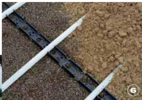
**FOTO 5.** Installazione impianto di riscaldamento e ritombamento con sabbia naturale fine Vaga 0,1-2 mm
