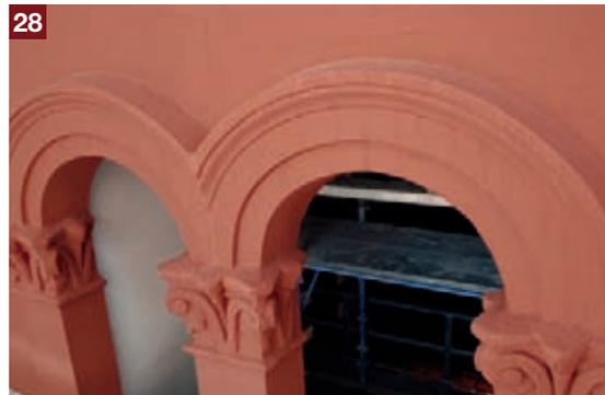
pittura a base di resina acrilica pura in dispersione acquosa per la protezione e la decorazione di superfici esterne e interne, previa applicazione di MALECH, fondo a base di resine acriliche micronizzate in dispersione acquosa.
