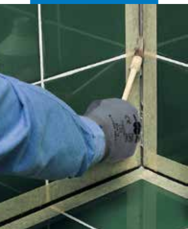
Aplicación de Primer FD
