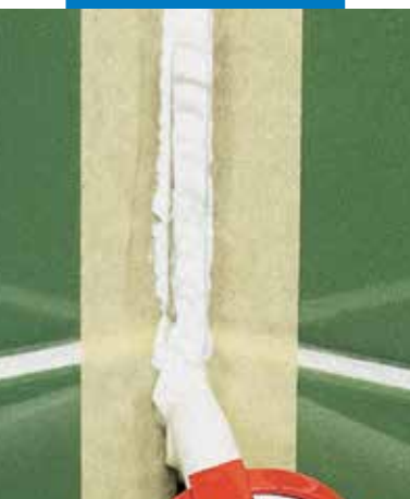
Aplicación de Mapesil AC
