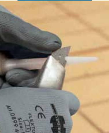
Corte de la boquilla de acuerdo con el tamaño de la junta
