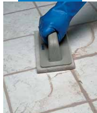
Reinigung des Belages
