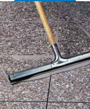
Einfugen einer Bodenfläche mit Keracolor FF Flexfuge
