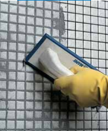
Verfugung von Glasmosaik mit Keracolor FF Flexfuge+ Fugolastic
