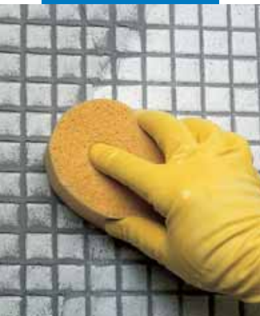
Reinigung mit feuchtem Schwamm
