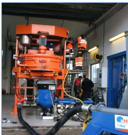
Betonblander og pumpe.
