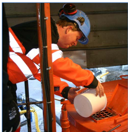
Tilsætningsstof blandes i betonen.
