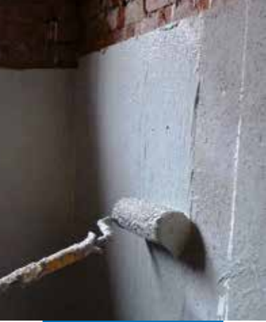
Aplicación de Mapelastic Foundation a rodillo, sobre soporte previamente regularizado con Planitop HDM Maxi
