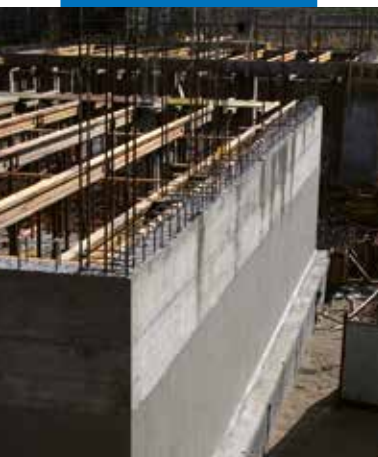
Muro de contención de tierras impermeabilizado después del hormigonado con Mapelastic Foundation
