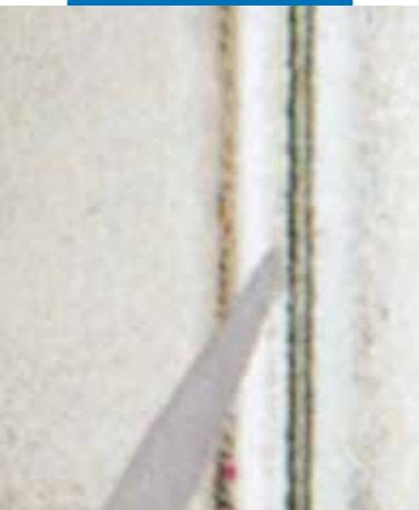
Sellado de vidrios perfilados en U
