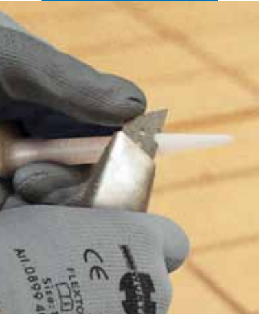
Cortar la boquilla según las dimensiones de la junta
