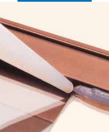
Sellado de carpintería de aluminio con Mapesil AC
