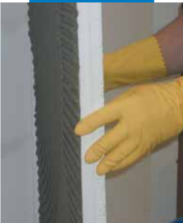
Τοποθέτηση του θερμομονωτικού πάνελου
