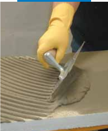
Εφαρμογή του Mapetherm AR1 στην πλάτη του μονωτικού φύλλου με οδοντωτή σπάτουλα
