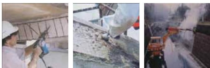
Odstranjivanje oštećenog betona
