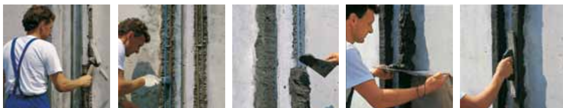
Sanacija armature uz primjenu jednokomponentnog tiksotropnog morta s normalnom brzinom vezanja
