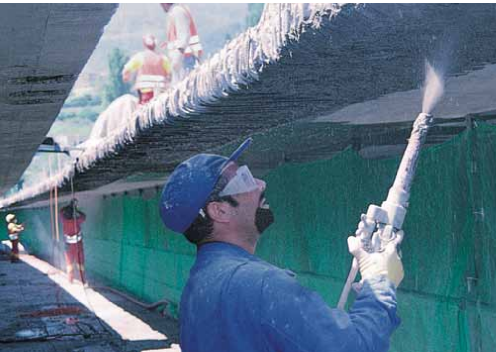
Postupak sanacije i zaštite betona
