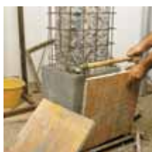
Strukturalna sanacija uz primjenu jednokomponentnog morta visoke fluidnosti i dobrih mehaničkih svojstava
