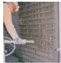
Nanošenje sanacijskog morta špricanjem
