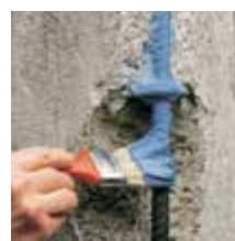
Zaštita armature uz primjenu Mapefer-a
