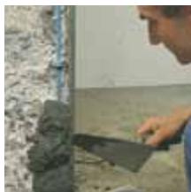
Postupak sanacije i zaštite betona
