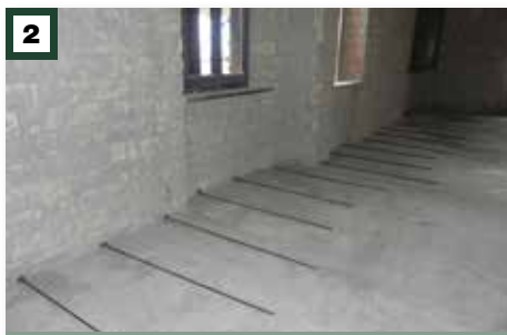
Ancoraggio perimetrale con monconi metallici
