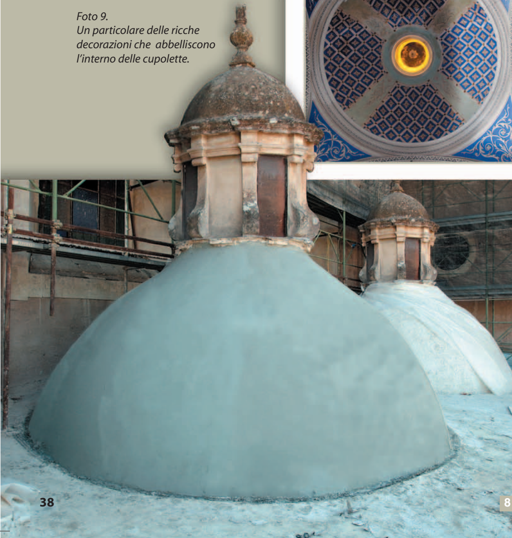
Foto 8. L'esterno delle cupolette al termine dei lavori di recupero.
