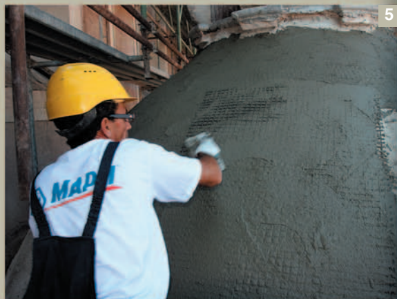
Foto 5. Dopo la posa della rete Mapegrid G220 è stato steso un secondo strato di Planitop HDM.
