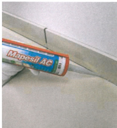
Forsegl glippen mellom listene og gulvet med en egnet, elastisk fugemasse fra Mapeis produkter
