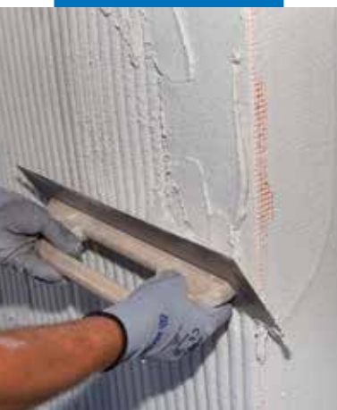
Påføring av første pusslag med Mapetherm AR1 Light
