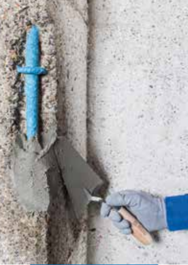
Påføre Planitop Smooth & Repair R4 med en murerkje
