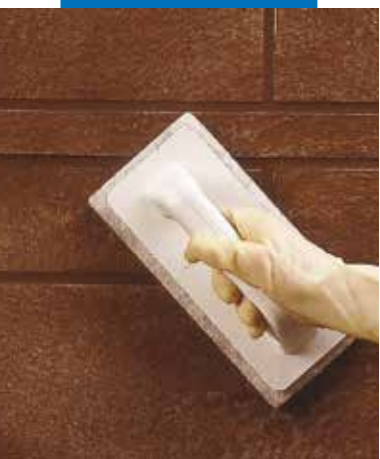
Fuging av vegg med gummibrett
