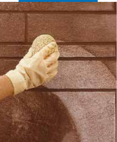
Vasking og sluttbearbeiding av vegg med svamp
