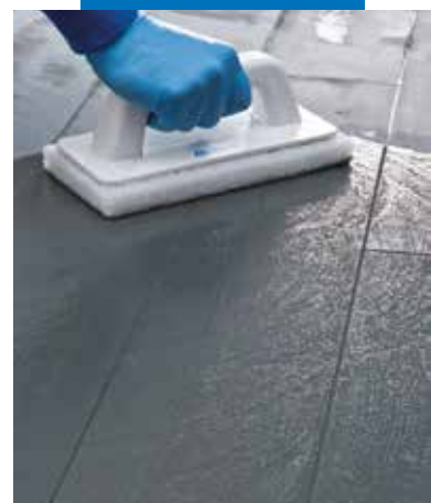
Vasking av fuger med Scotch-Brite® skurepute (produkt delvis herdet)
