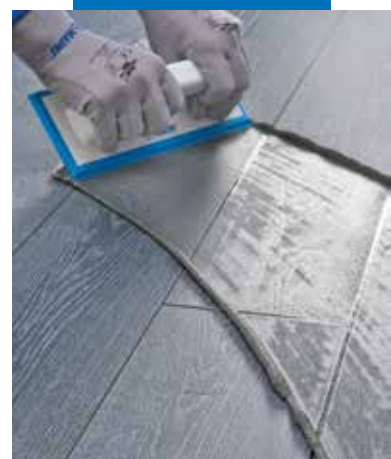
Fuging av Ultracolor Plus på fliser med trestruktur med gummibrett
