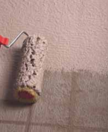
Impermeabilización de muro de cimentación a rodillo
