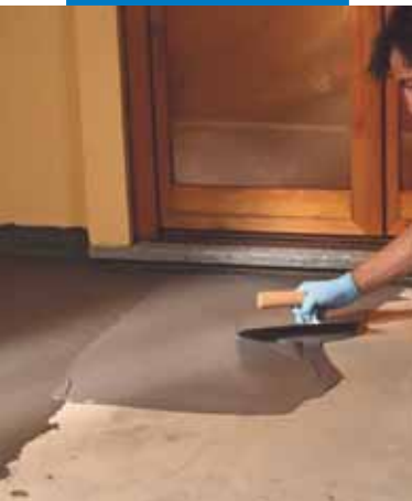
Impermeabilización de arqueta de hormigón a brocha
