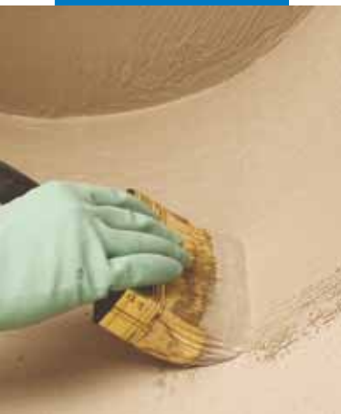
Impermeabilización de muro de cimentación a brocha
