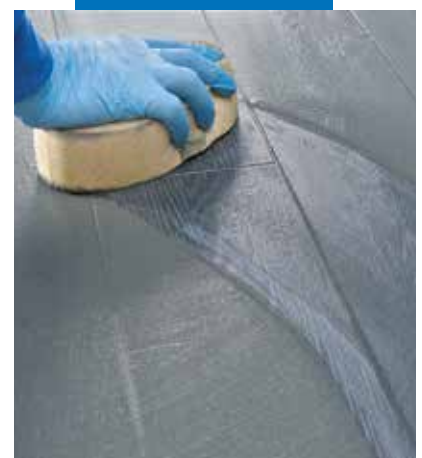
Limpieza y acabado de las juntas con esponja de celulosa dura
