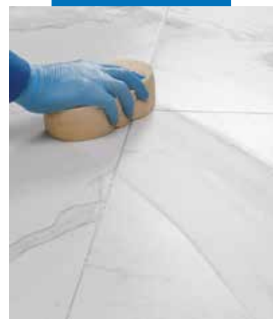
Limpeza y acabado de las juntas con esponja de celulosa dura
