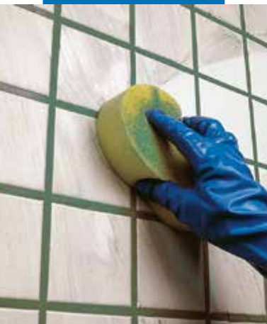
Limpieza y acabado de las juntas en pared con esponja
