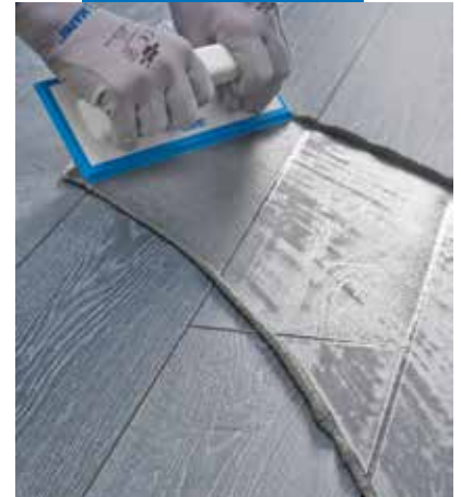
Aplicación de Ultracolor Plus en pavimento con llana de goma, sobre baldosas de gres porcelánico efecto madera
