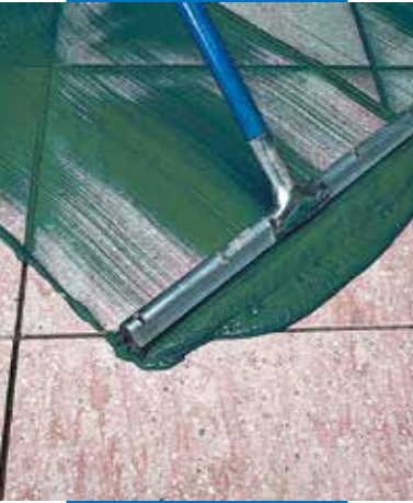
Aplicación de Ultracolor Plus en pavimento con rastrillo de goma grande
