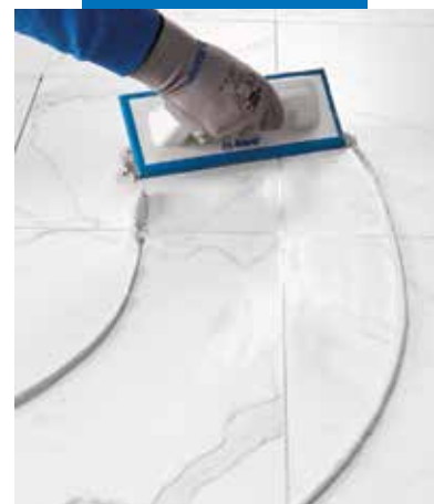
Aplicación de Ultracolor Plus en pavimento con llana de goma sobre baldosas de gres porcelánico efecto mármol
