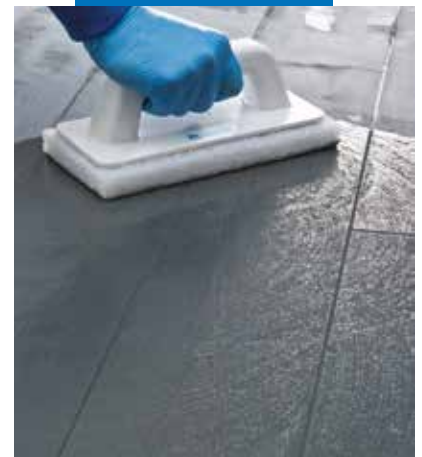
Limpieza de las juntas con Scotch-Brite (con el producto parcialmente endurecido)
