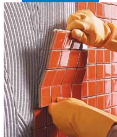
Aplicação de revestimento de mosaico cerâmico
