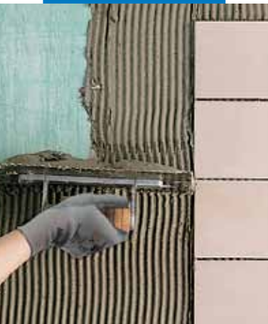
Aplicação sobre gesso tratado com Primer G
