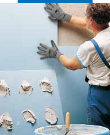
Aplicação de lastras em polistireno com Keraflex branco
