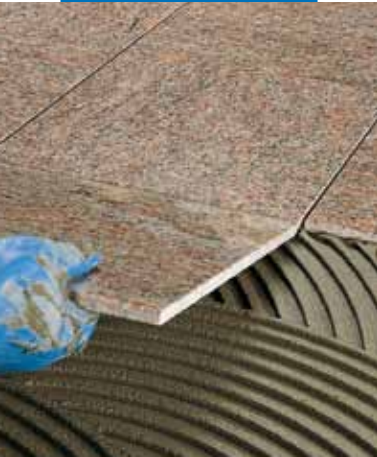
Assentamento em pavimento de mármore prépolido
