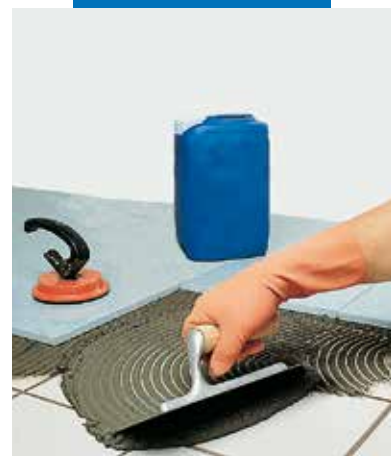
Sobreposição de aglomerado sobre cerâmica existente com Granirapid cinza
