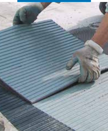
Assentamento de borracha com reverso em cimento com Granirapid
