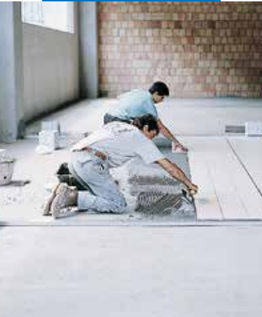
Assentamento de grés porcelânico em ambiente industrial
