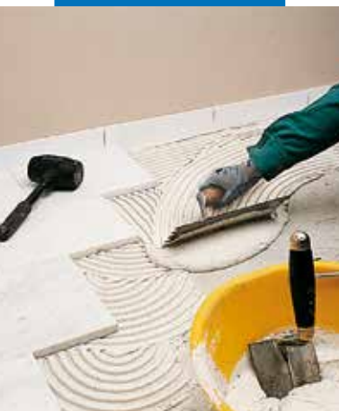
Assentamento de mármore de Carrara branco com Granirapid branco
