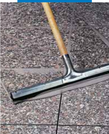
Betumação de juntas de pavimento em granito prépolido com rodo
