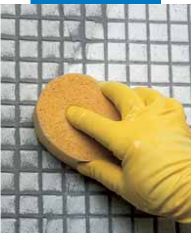
Acabamento de revestimento em pastilha de vidro com esponja
