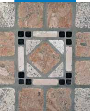
Exemplo de betumação de juntas em pavimento envelhecido em pedra natural
