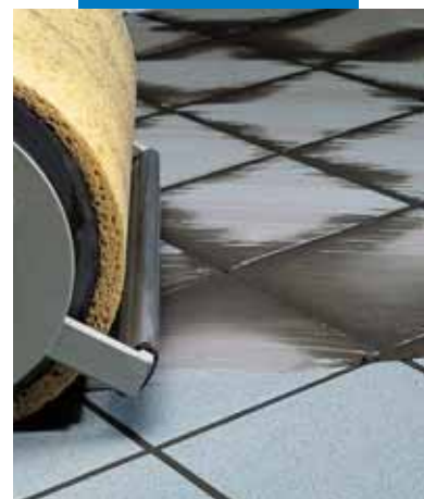
Acabamento de pavimento com máquina
