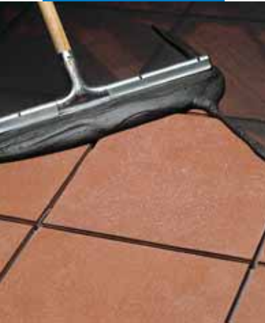
Betumação de pavimento em tijoleira com rodo
