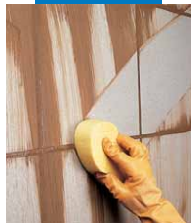
Acabamento de parede com esponja
