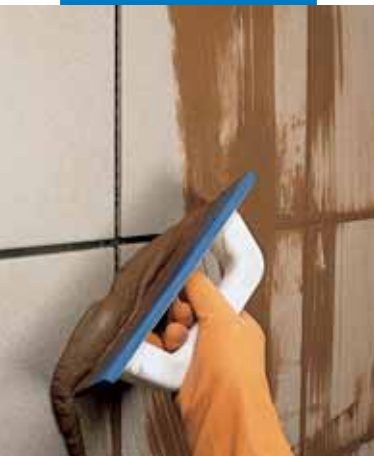
Betumação de revestimento exterior com espátula
