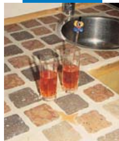
Exemplo de colagem e execução de juntas de tempo da cozinha
