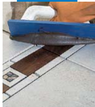
Execução de juntas em pavimento cerâmico inserções em madeira com espátula
