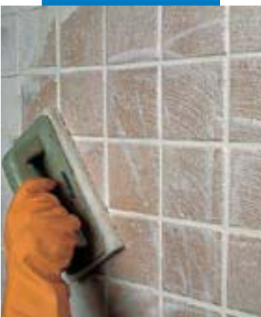
Acabamento de ladrilhos de monocozedura com Scotch-Brite®
