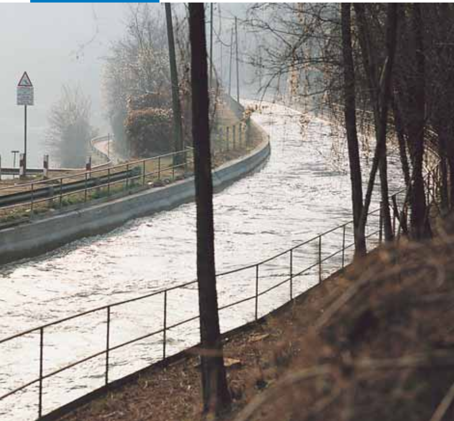
Canal hidroeléctrico Bertini - Robbiate (CO), tratado à superfície com Idrosilex Pronto
