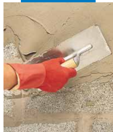
Aplicação de Idrosilex Pronto à espátula
